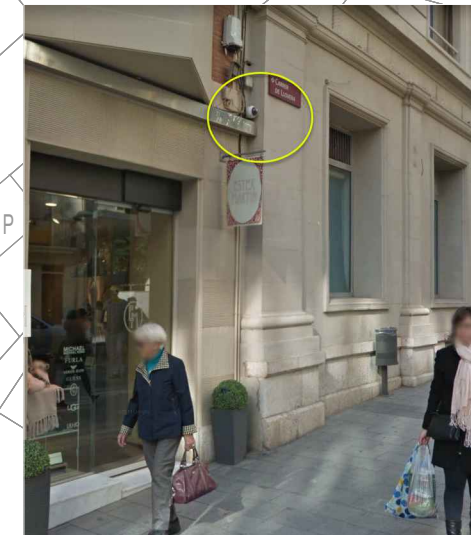
3 FOTO CAMARA ACTUAL A SUBSTITUIR
