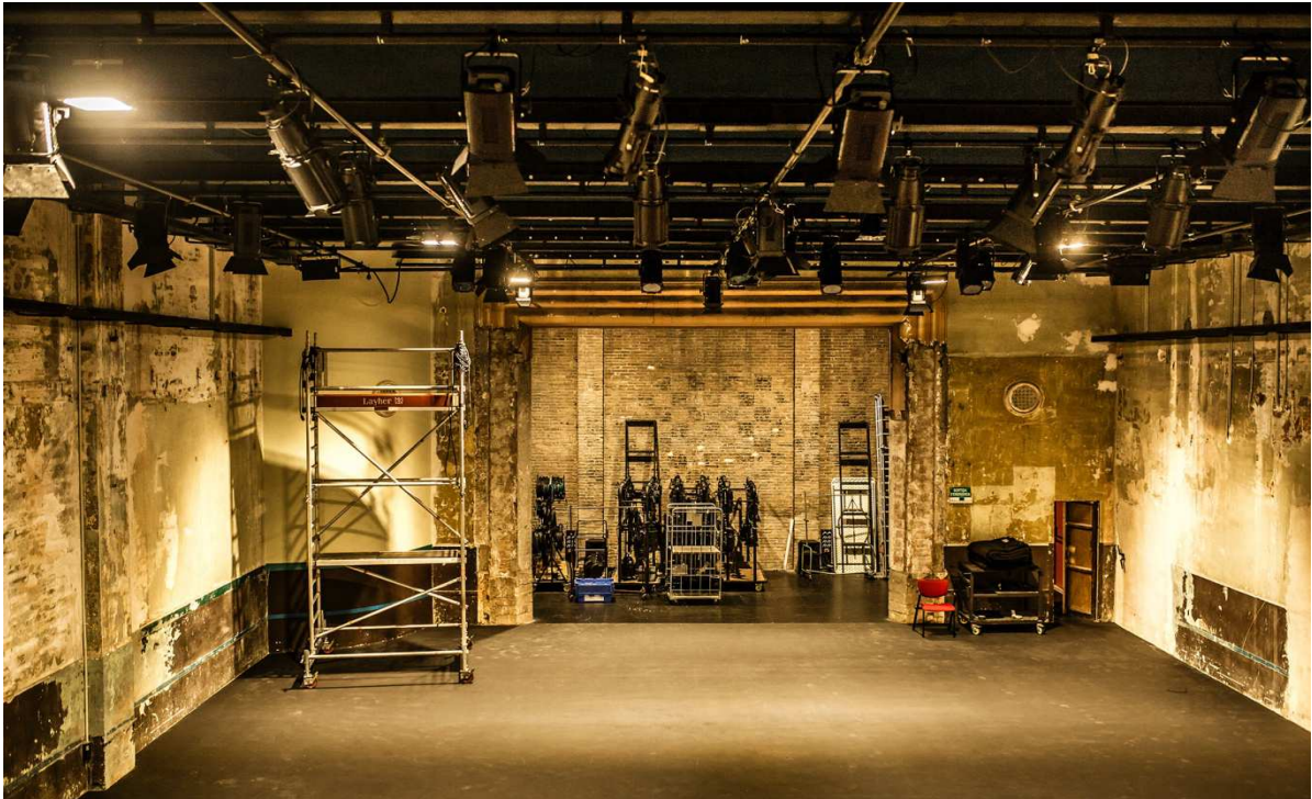
Exemple de sostre tècnic, Sala Beckett
