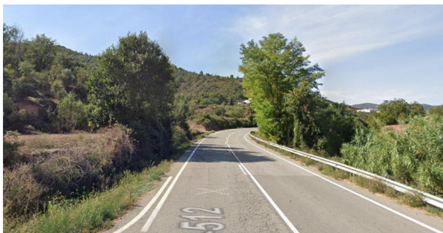
Imatge 17. Entrada direcció Trempt via L-512 PPKK 0+700
