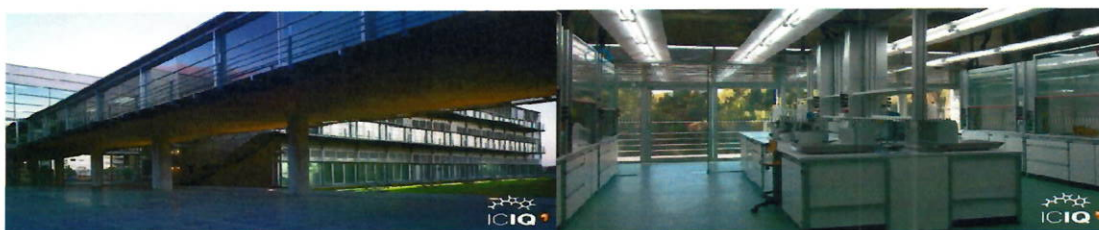
Vista de l'edifici (pont connexió de la "H")
