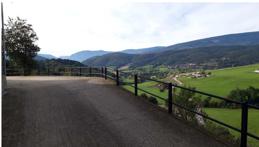
FOTO 4: Vista de barana existent - BELLESTAR
