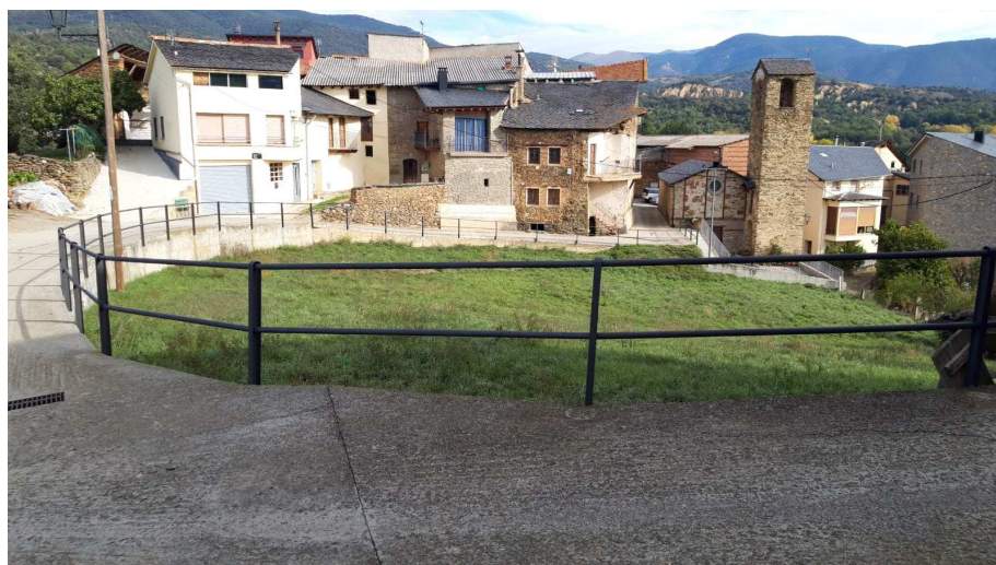
FOTO 5: Vista de barana existent - BELLESTAR
