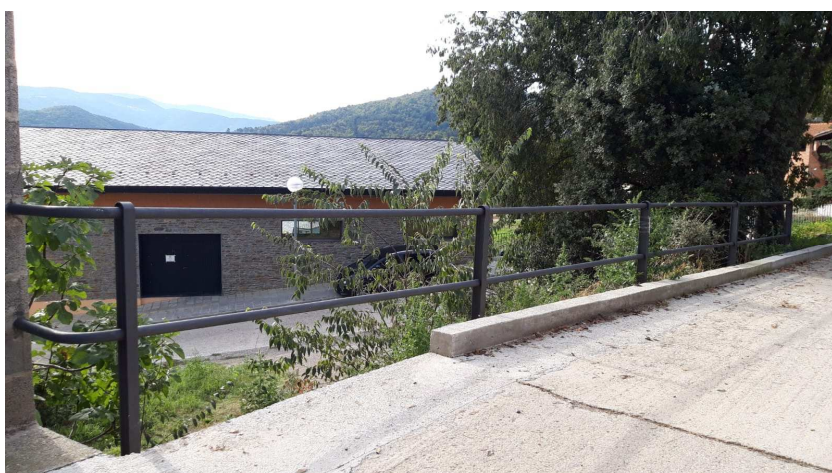
FOTO 2: Vista de barana existent - ARAVELL
