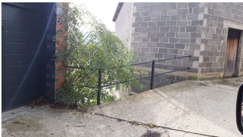
FOTO 1: Vista de barana existent - ARAVELL
