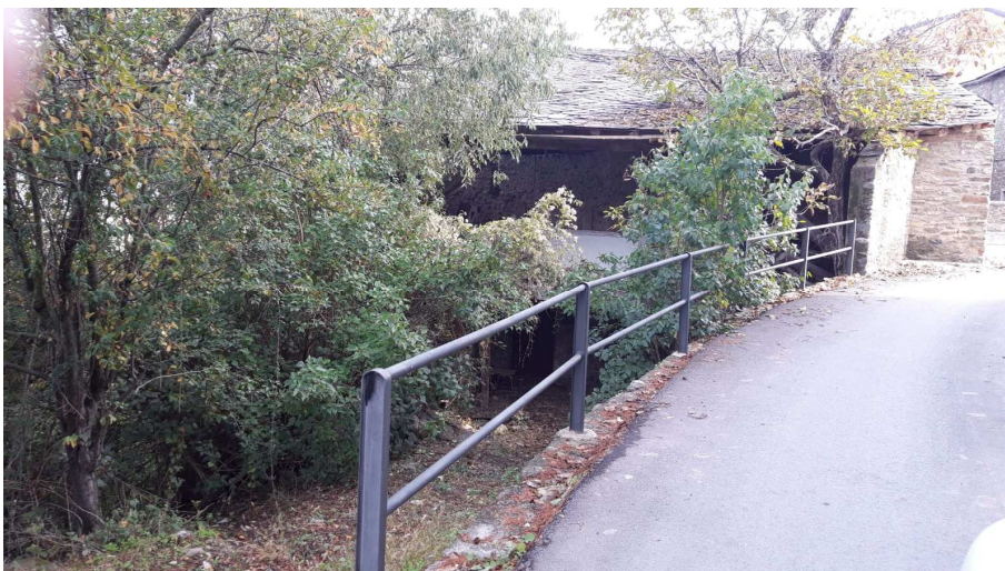
FOTO 7: Vista de barana existent - MONTFERRER
