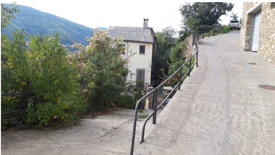
FOTO 8: Vista de barana existent - MONTFERRER
