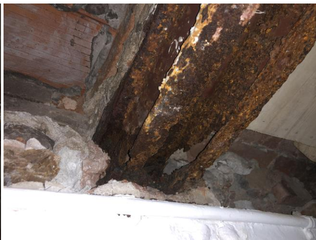
Imatges 012 i 013. Estat de les bigues de ferro d'ala estreta del forjat de la galeria en planta baixa, amb diversos graus d'oxidació. Font: Elaboració pròpia.
