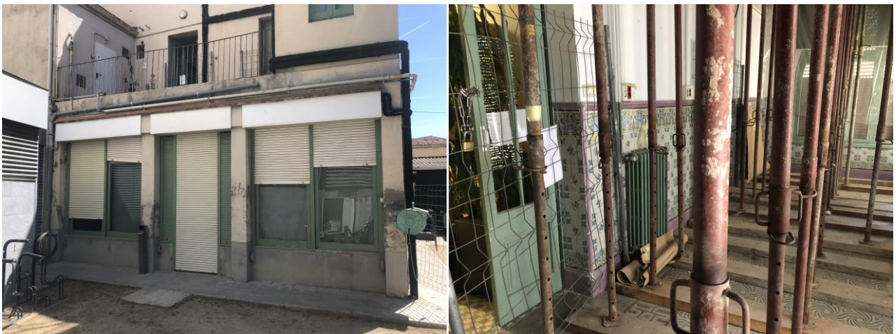
Imatges 006 i 007. Vistes de l'interior i l'exterior de la galeria en planta baixa. Font: Elaboració pròpia.
