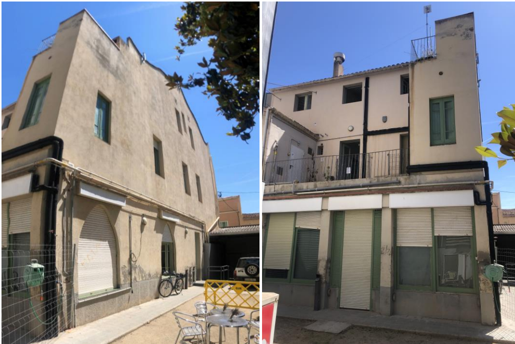
Imatges 004 i 005. Façana sud, i façana oest amb galeria en planta baixa. Font: Elaboració pròpia.
