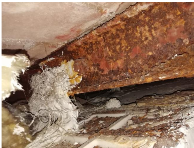
Imatges 010 i 011. Estat de les bigues de ferro d'ala estreta del forjat de la galeria en planta baixa, amb diversos graus d'oxidació. Font: Elaboració pròpia.
