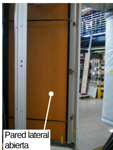
Figura 23: Desmontaje de la pared lateral
