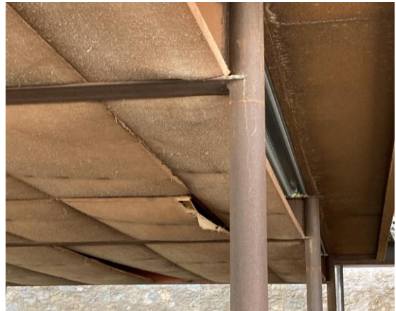
Degradació de la tela de sac de les cobertes per acumulació d'humitat en les zones perimetrals dels panells fets d'estructura de fusta. Font: Muntant Arquitectura Cooperativa
