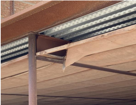
Degradació de la tela de sac de les cobertes per acumulació d'humitat en les zones perimetrals dels panells fets d'estructura de fusta. Font: Muntant Arquitectura Cooperativa
