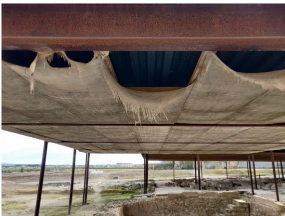
Degradació de la tela de sac de les cobertes per l'efecte del vent i el sol en les zones perimetrals de les cobertes. Font: Muntant Arquitectura Cooperativa
