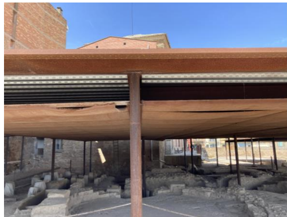
Degradació de la tela de sac de les cobertes per l'efecte del vent i el sol en les zones perimetrals de les cobertes. Font: Muntant Arquitectura Cooperativa
