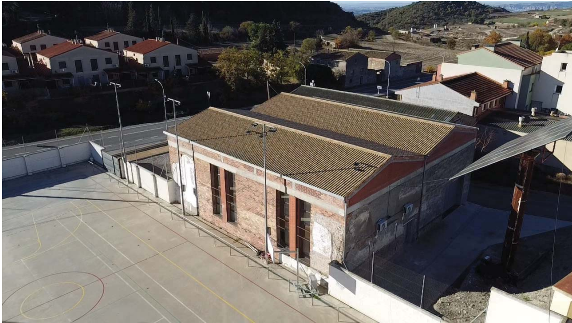
Imatge aèria de l'estat actual de l'edifici en la façana nord-est
