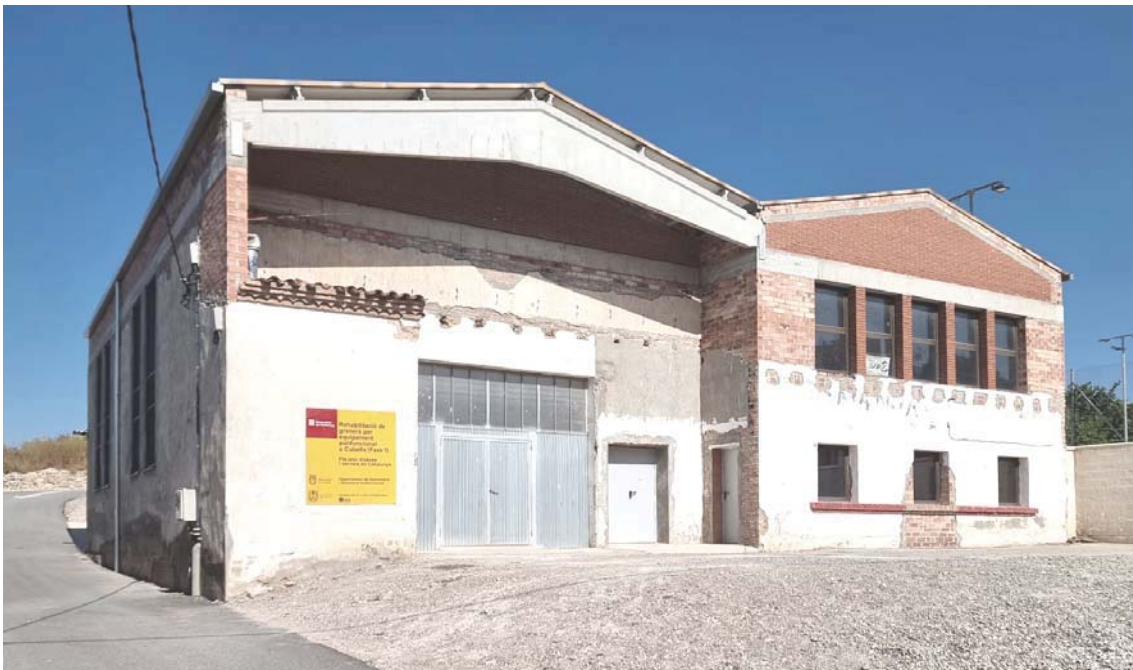
Estat actual de l'edifici
