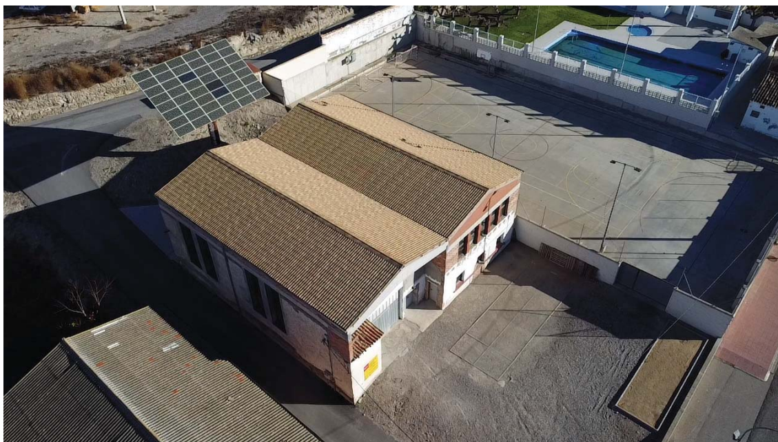
Imatge aèria de l'estat actual de l'edifici en la façana sud-oest
