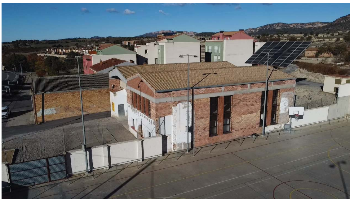
Imatge aèria de l'estat actual de l'edifici en la façana sud-est
