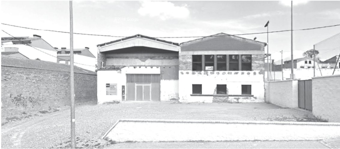
Estat actual de la façana principal
