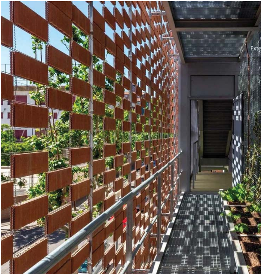
Imatge del sistema constructiu, on es pot apreciar la transparència del conjunt.
