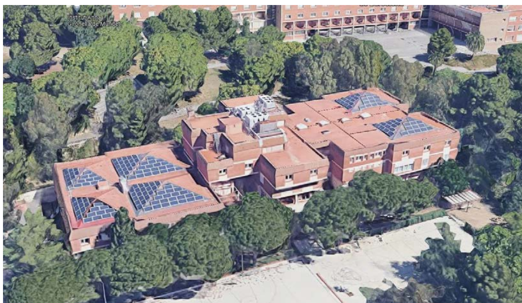
Vista general de l'edifici Serradell i Trabal
