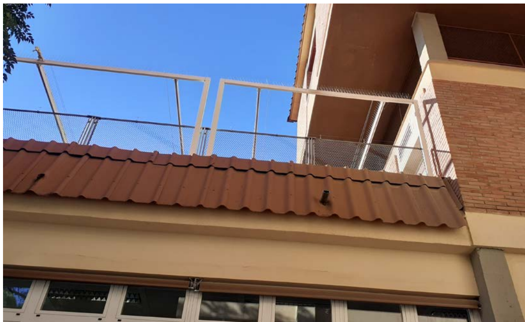
Foto 01. Plaques ondulades de fibrociment
