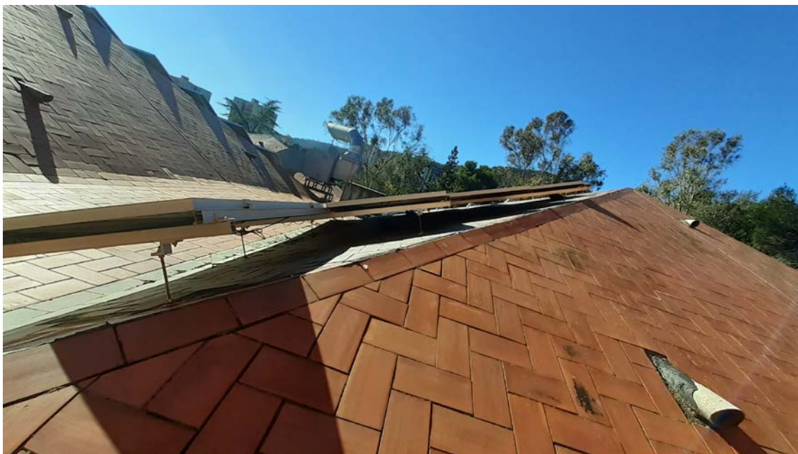
Vista de piràmide de coberta amb ventilació de fibrociment (1)
