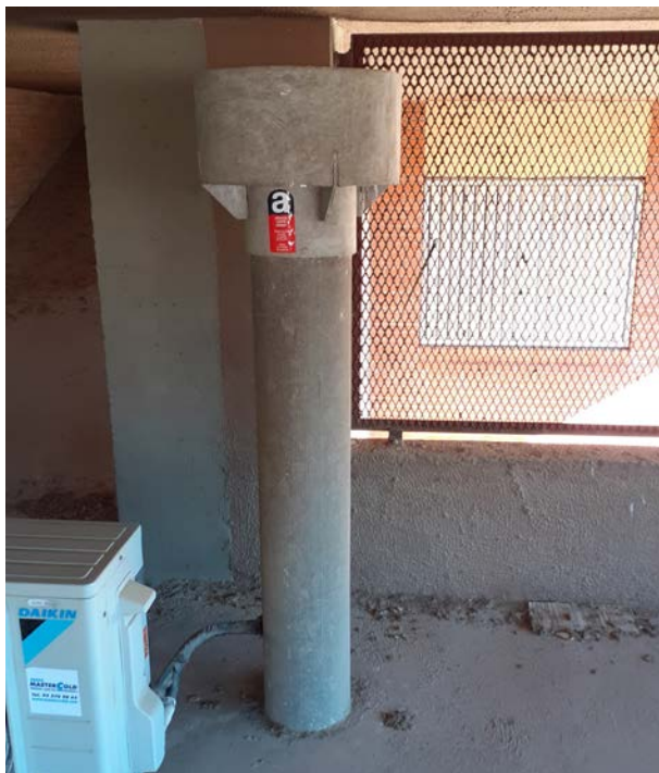
Foto 03. Barret de coronació de conductes de ventilació
