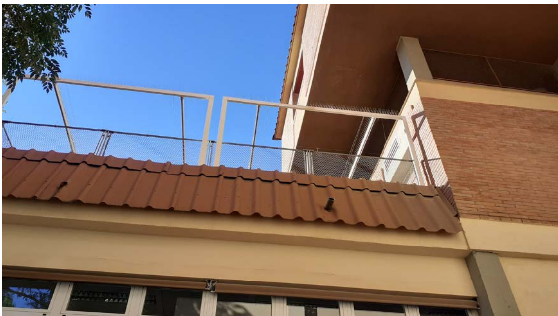
Plaques de fibrociment en revestiment de façana
