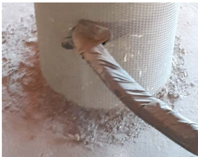
Foto 07. Detall de la instal·lació de clima per l'interior del conducte
