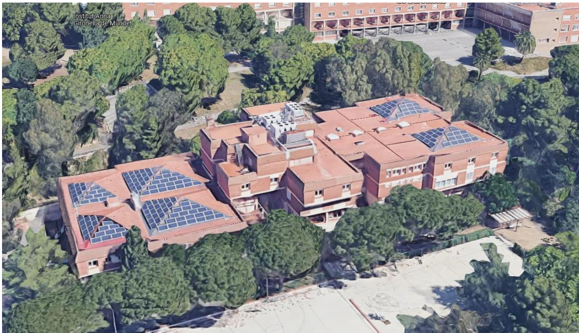
Vista general de l'edifici Serradell i Trabal
