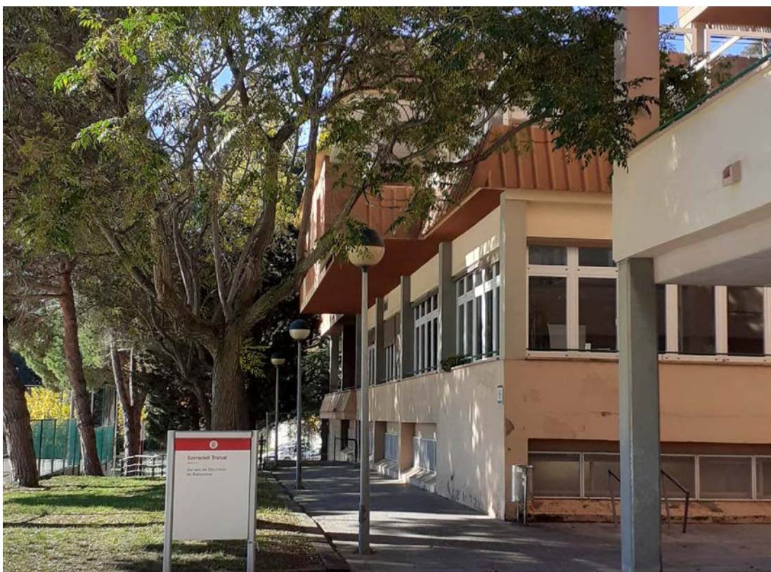
Vista lateral edifici Serradell i Trabal
