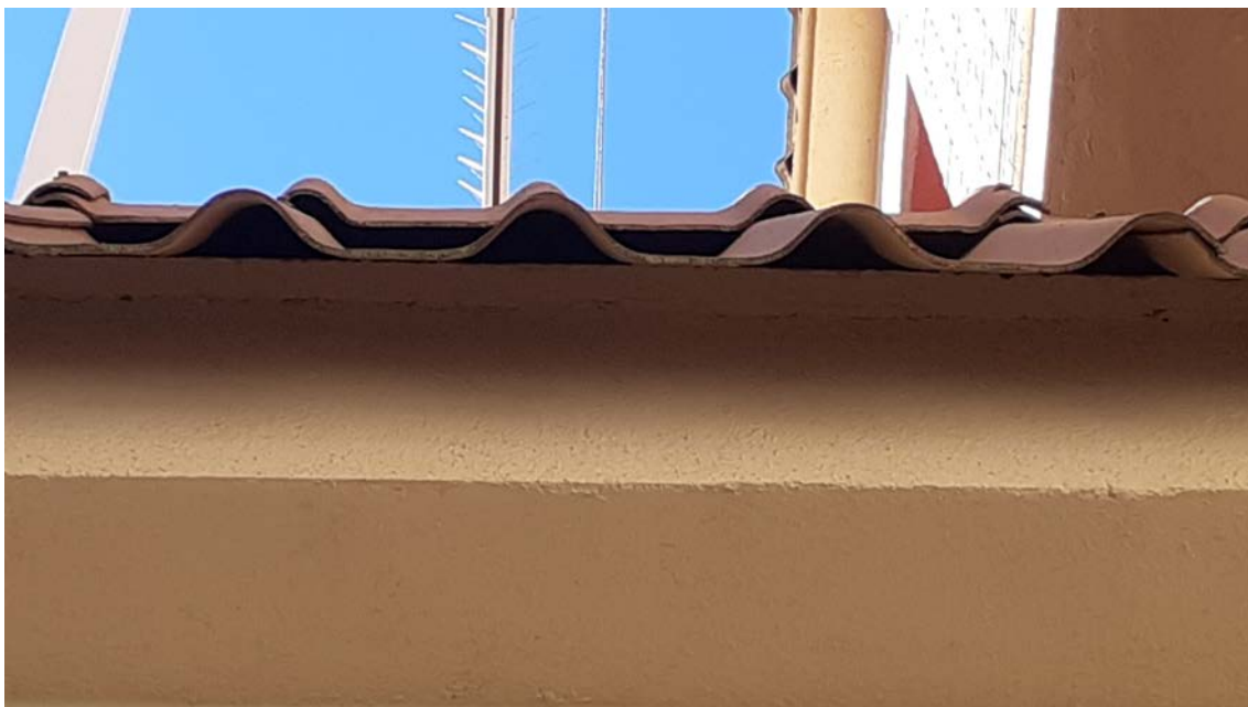
Detall de plaques de fibrociment de façana
