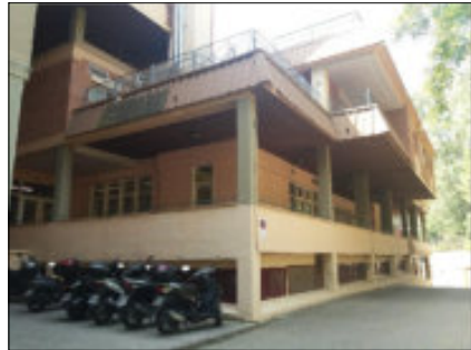
vista per sota façana nord
