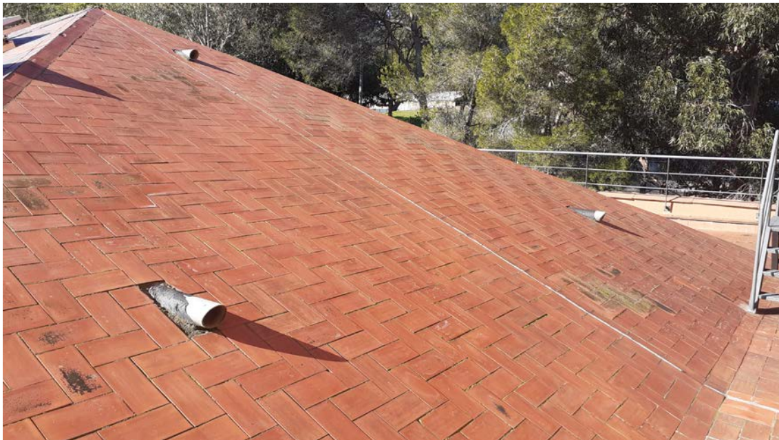
Vista de piràmide de coberta amb ventilació de fibrociment (2)
