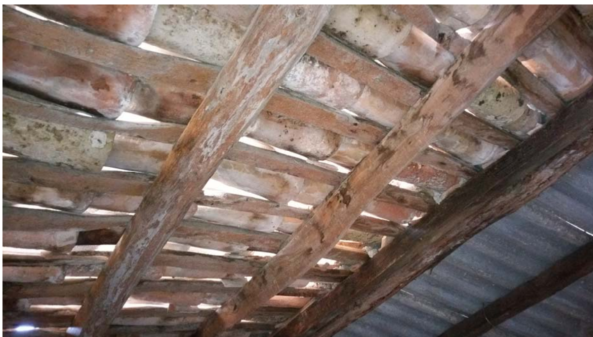
Estat actual de la coberta
