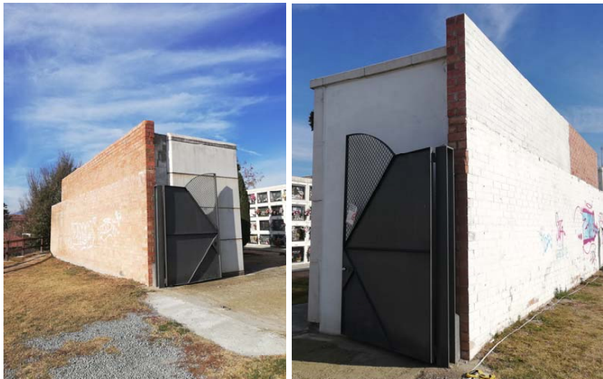
Vista de la façana oest de la part nova del cementiri. El parament vertical de tancament es de mur ceràmic vist i amb graffitis a tota la part inferior del mur.
