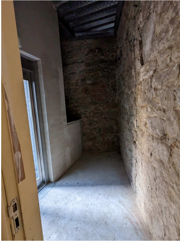
Espai d'arribada de l'ascensor a connectar amb el vestíbul d'accés del museu
