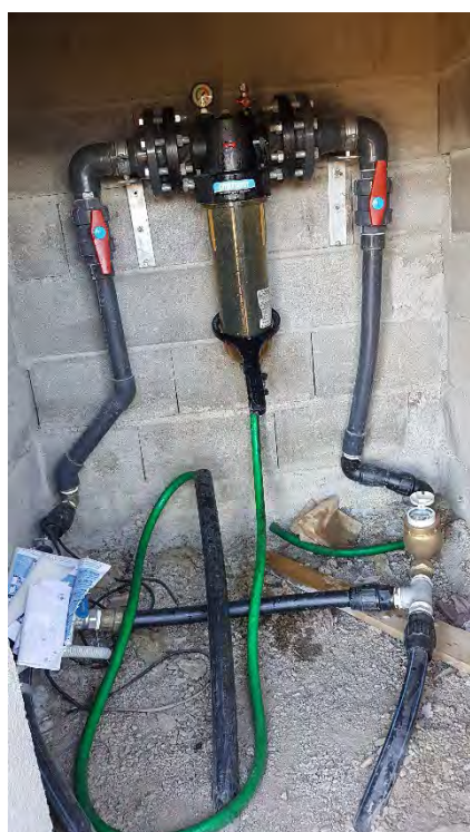
Foto 13: Equips de filtració desmuntar. Foto 14: Canonades en parcel·la 212 a retirar.
