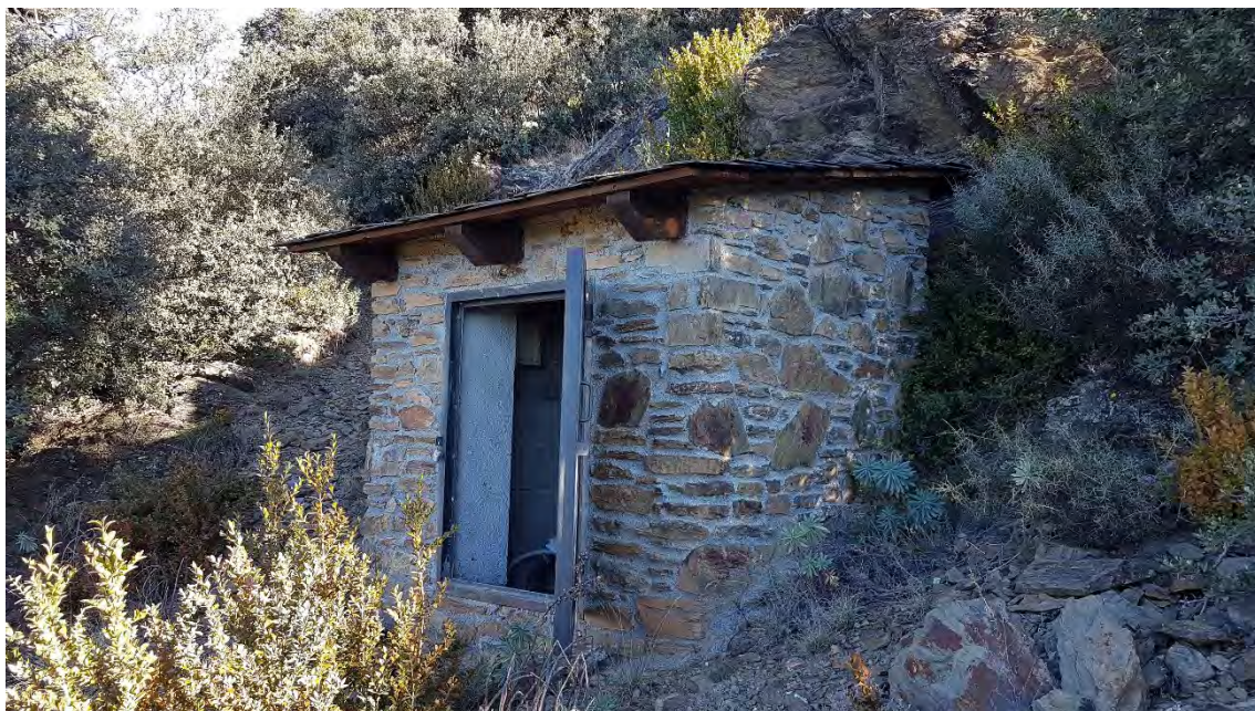
Foto 12: Caseta existent equips de filtració a desmuntar.
