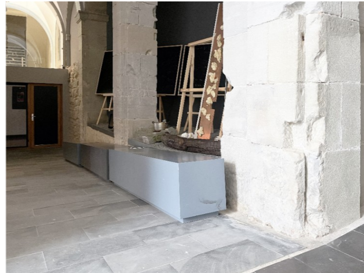
07_RAMPA ACCÉS LAVABOS
