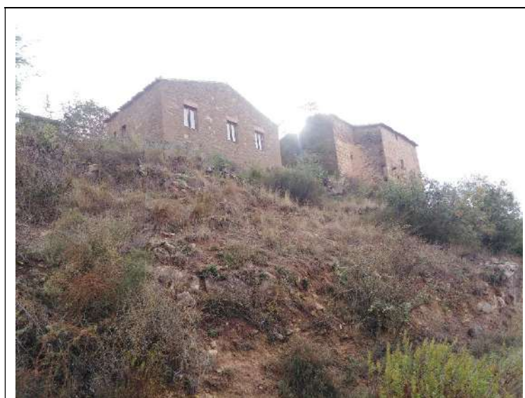
Vista de la façana oest de l'edificació on es projecta l'ampliació
