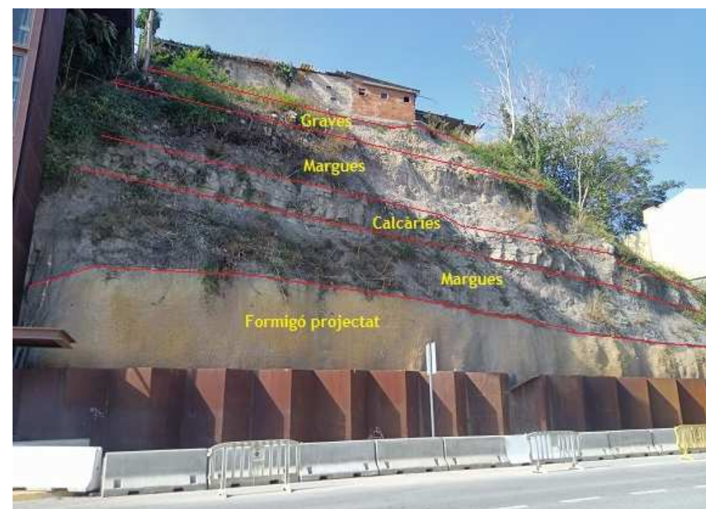
Figura 7: Visió de la distribució dels diferents estrats i actuacions en el talús un cop esbrossat i sanejat.
