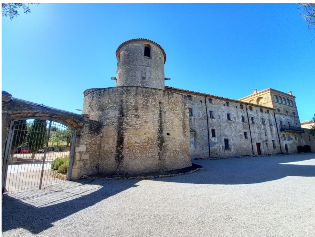
Plaça d'accés al Castell del Penyafort
