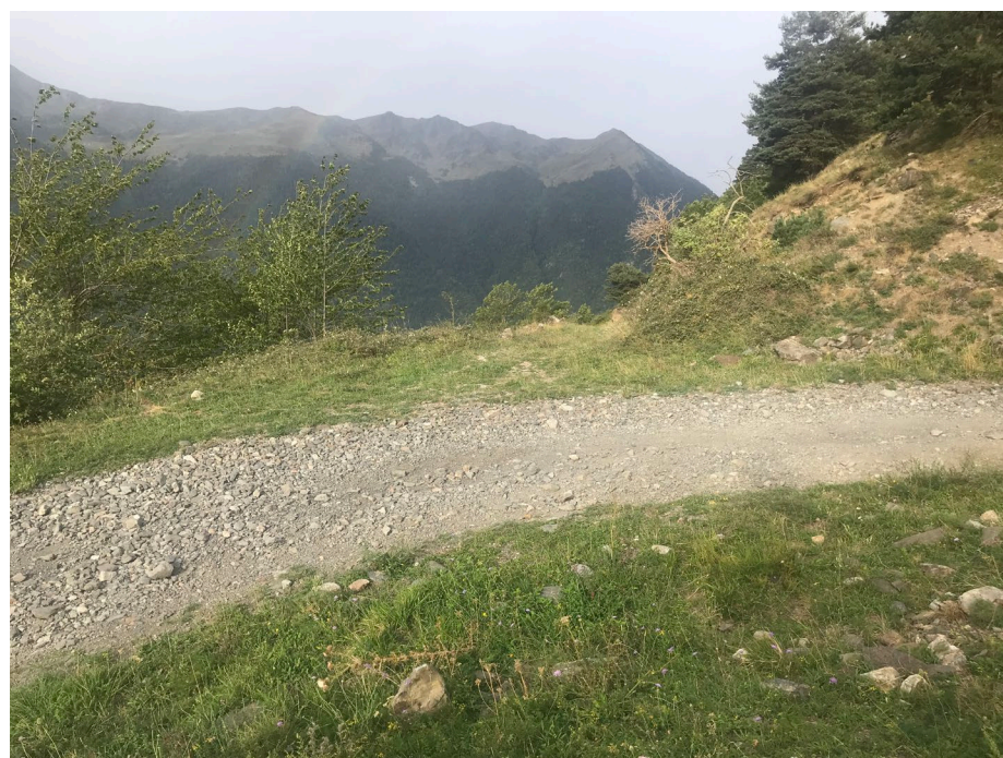
Foto 8 Desviament cap al dipòsit municipal d'aigua potable del nucli de Vilamòs per camí no pavimentat.
