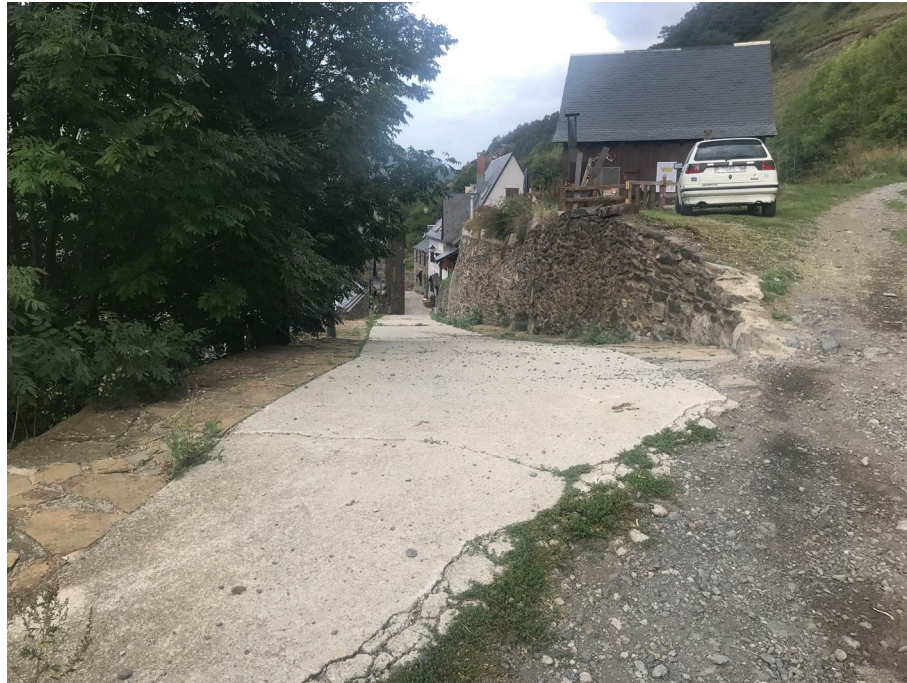
Foto 3 Entroncament del C/St. Antoni, punt d'inici dels treballs de millora i pavimentació de la pista d'Uishèra.
