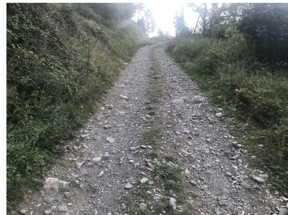
Foto 6 Tram de pista molt pedregós i forta pendent que dificulta la seva transibilitat inclús amb vehicles tot terreny, especialment amb condicions de pluja o neu.
