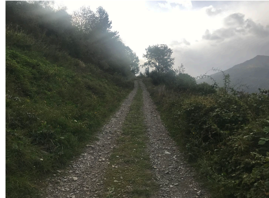
Foto 5 Tram de pista en trinxera amb els marges tan vegetats que limiten la seva secció útil.
