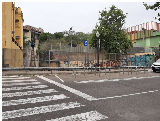
Vista general del tancament 4
