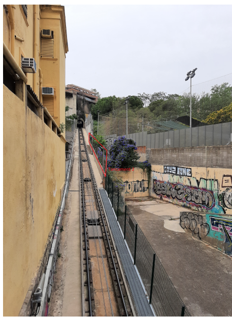
Vista general del tancament 2
