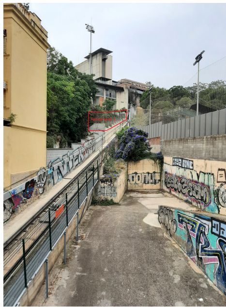
Vista general del tancament 1
