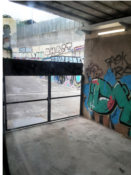
Vista general del tancament 3
