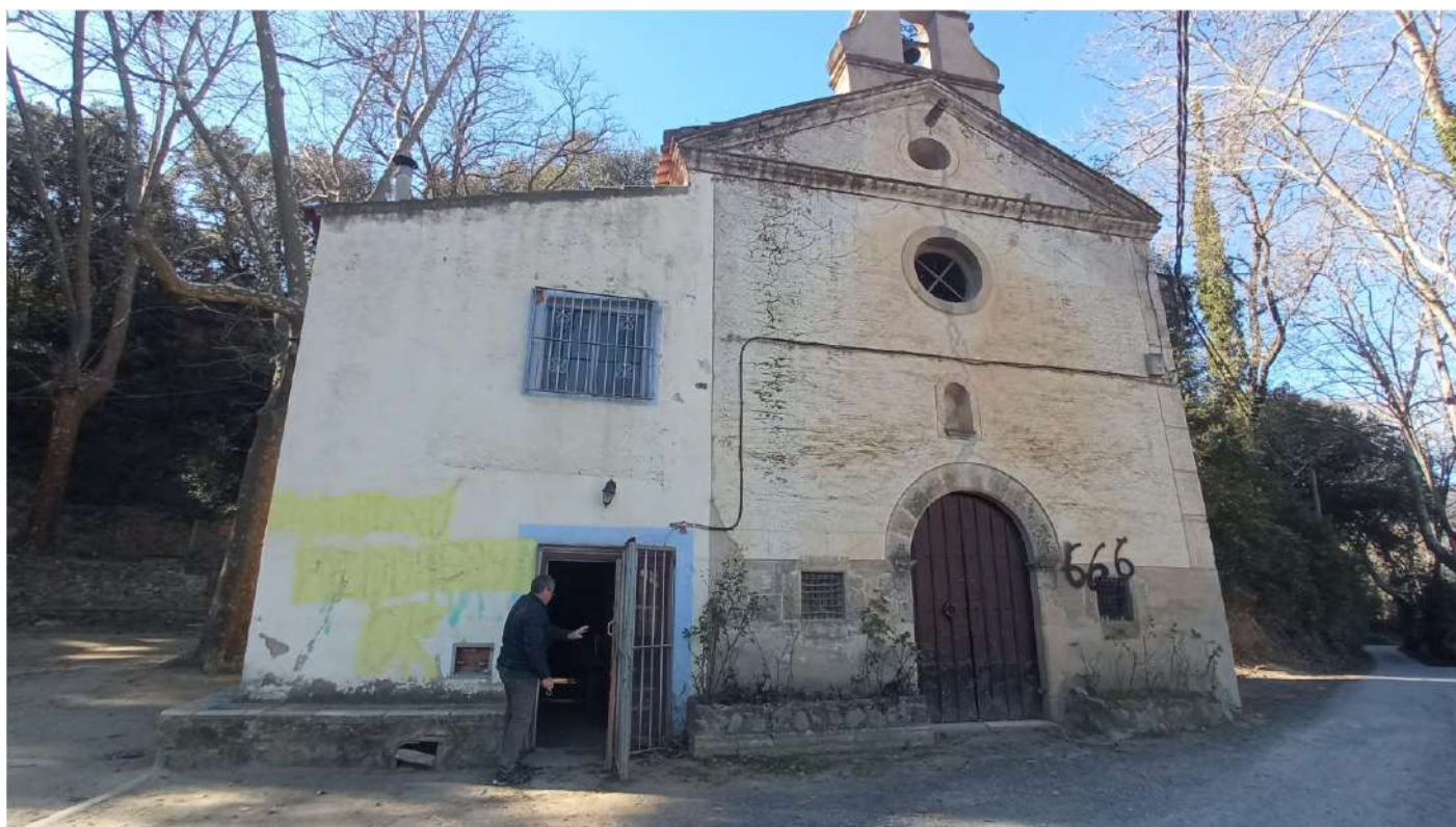
FAÇANA PRINCIPAL. FAÇANA NORT
