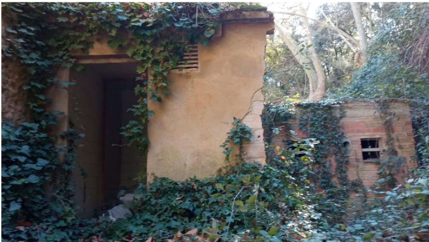
FAÇANA OEST BANY EN DESUS
