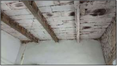
ESTRUCTURA DE COBERTA DE BIGUETES CERÀMIQUES
