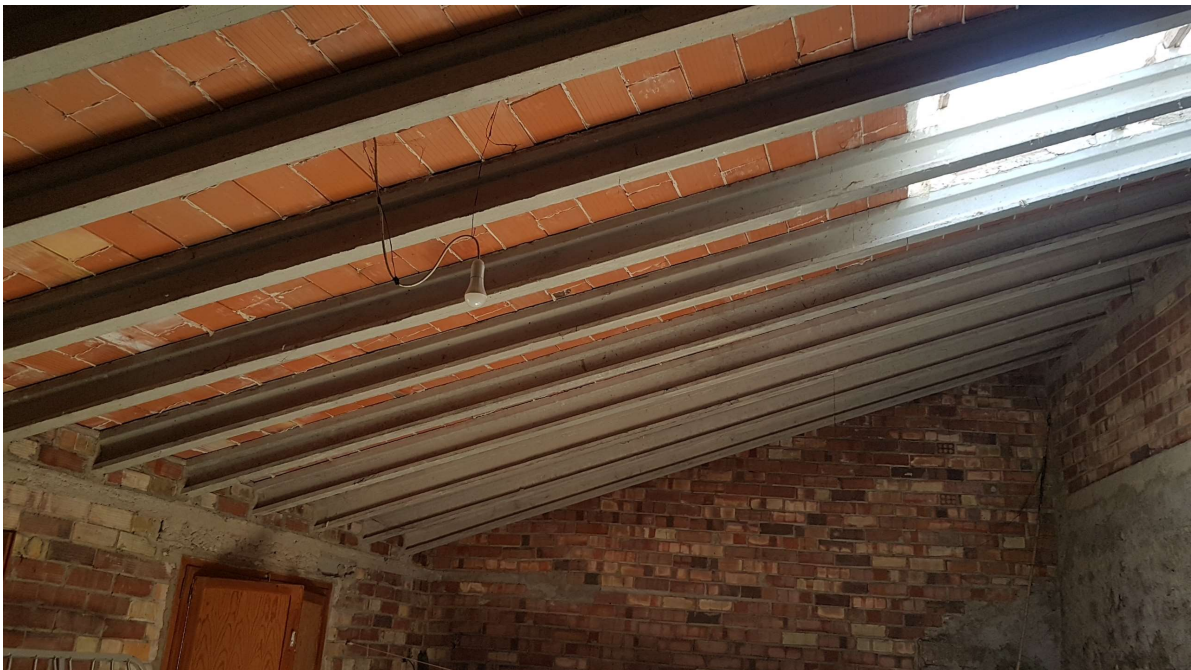
Estructura coberta de planta segona
