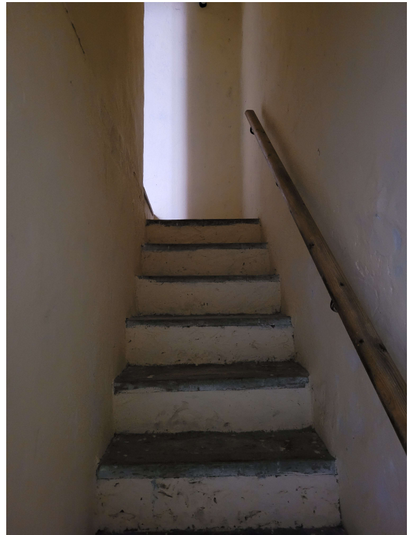
Escales d'accés als habitatges
