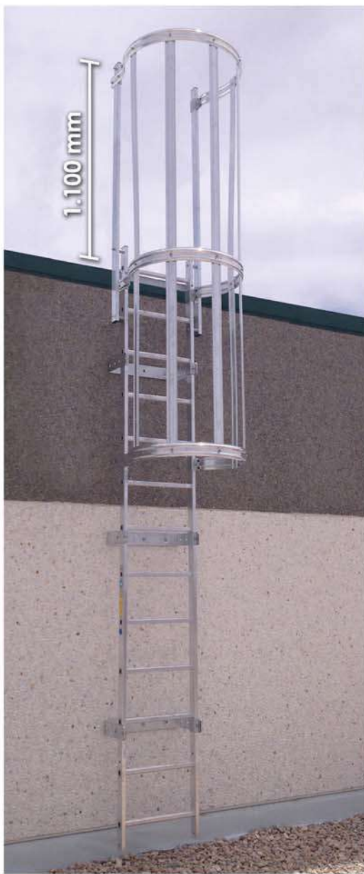
Altura mínima del aro superior de protección de espalda sobre la altura de desembarco: 1.100 mm
