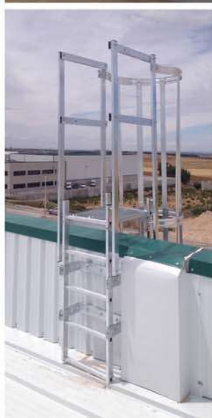
Altura mínima del aro superior de protección de espalda sobre la altura de desembarco: 1.100 mm
