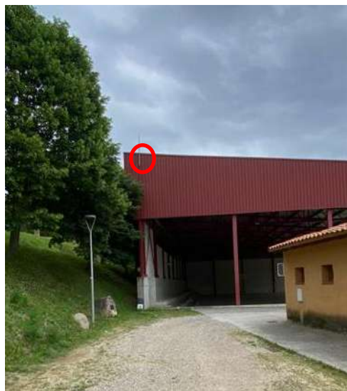
Il·lustració 8 - Paret que es perforarà per fer entrar el baixant
