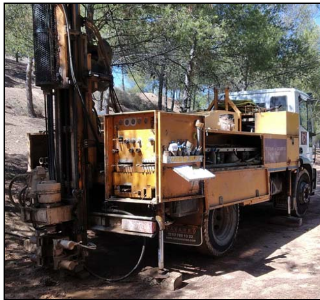
Fotografia 5. Vista de la màquina utilitzada per a la realització del sondeig a rotació S-1.
