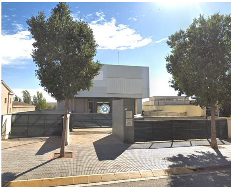
Il·lustració 3. Seu Infraestructures Tàrrrega
