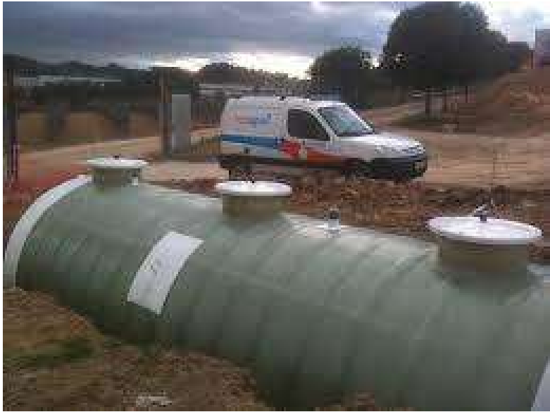
Il·lustració 9 i 10: Mostra de reactors tipus BT fabricats en PRFV (il·lustració orientativa similar a la futura EDAR de Soriguerola).
