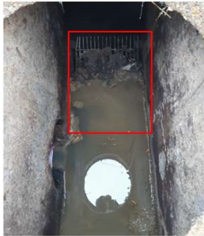
Il·lustració 9: Mostra aproximadament (requadre vermell) la ubicació de la nova reixa de gruixuts just a l'espai que ocupa l'actual reixa de l'EDAR.
