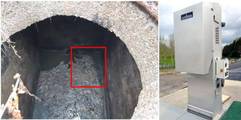
Il·lustració 13: A l'esquerra mostra aproximadament (requadre vermell) la ubicació del sistema de reixa automàtica just després de l'actual reixa de l'EDAR, a la dreta es mostra una reixa automàtica.
