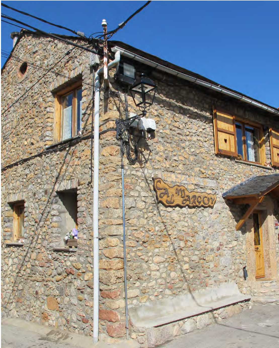
VISTA INSTAL·LACIÓ AÈRIA ACTUAL
