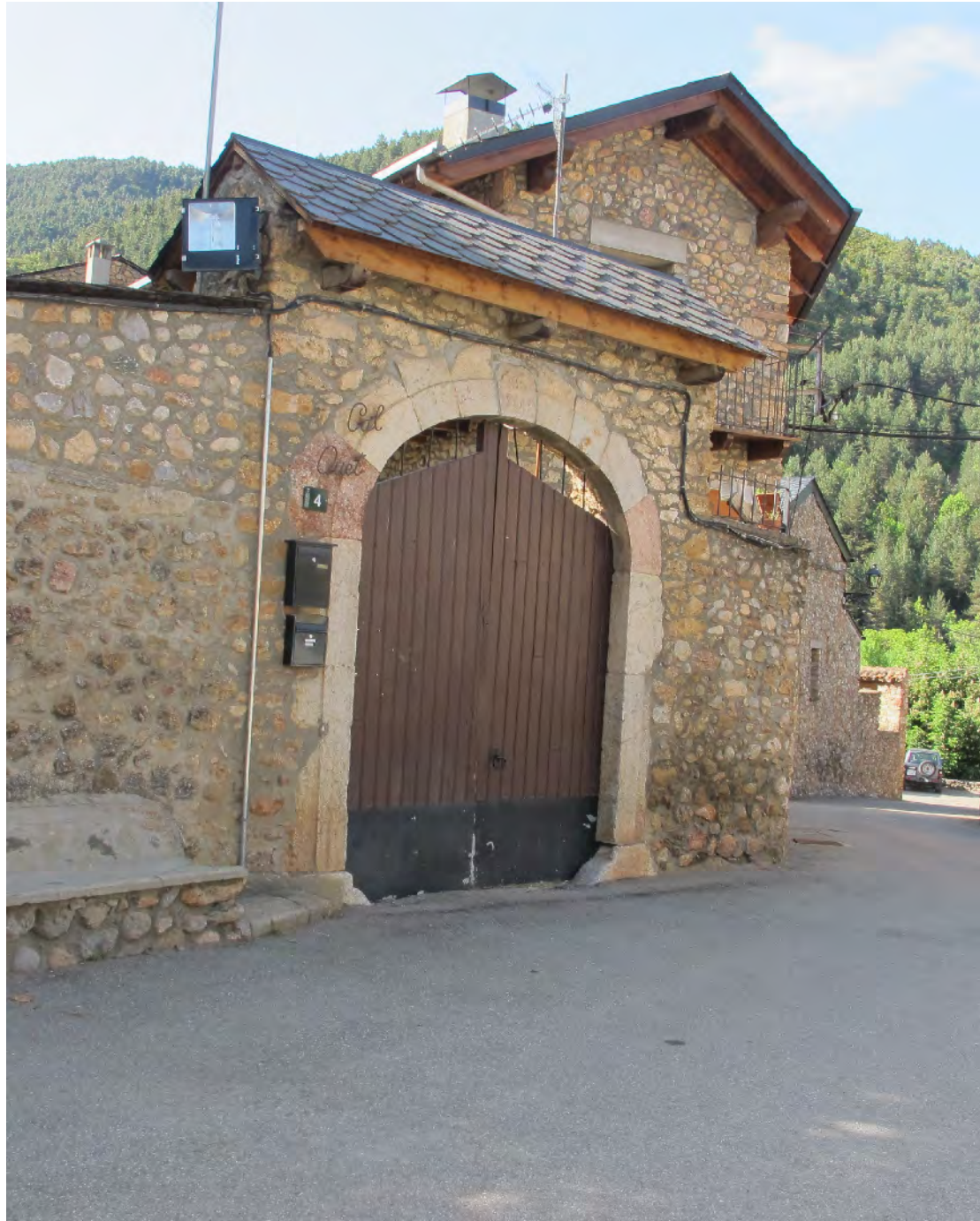
VISTA INSTAL·LACIÓ AÈRIA ACTUAL
