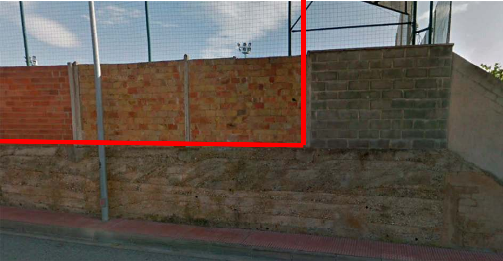
PUNT FINAL DE L'ENDERROC
