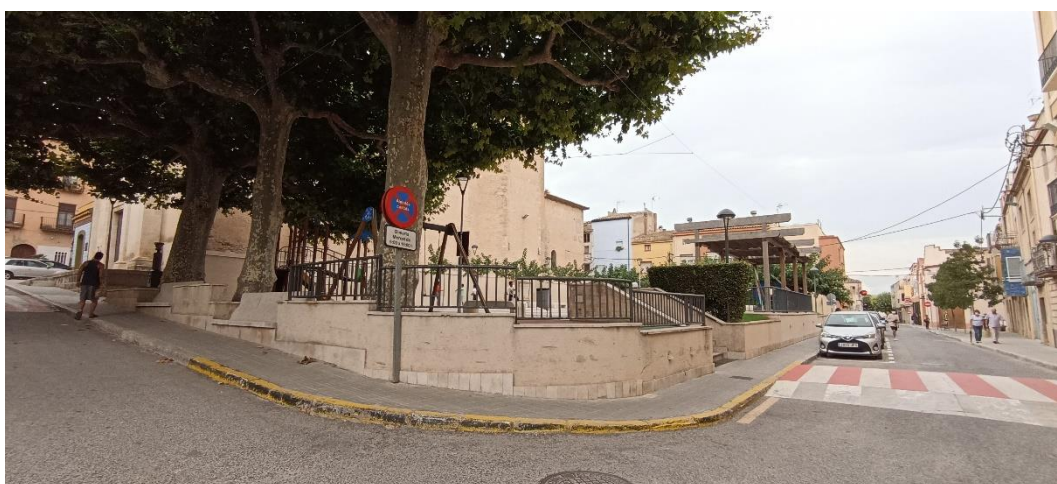
Il·lustració 4.- Façana nord i oest
