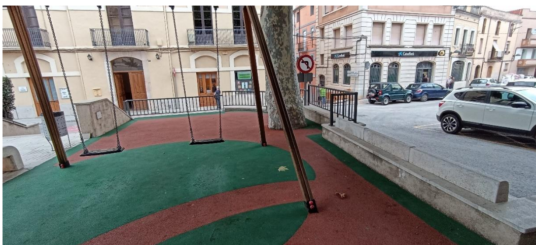
Il·lustració 19.- Mur perimetral de façana utilitzat com a banc
