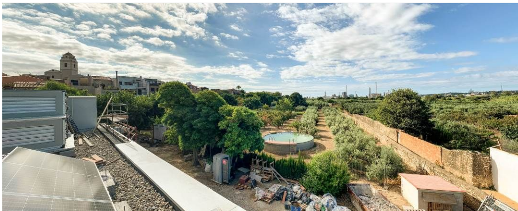
Imatge 1 : Vista de la zona a actuar des de la coberta del centre d'interpretació recentment ampliat.
