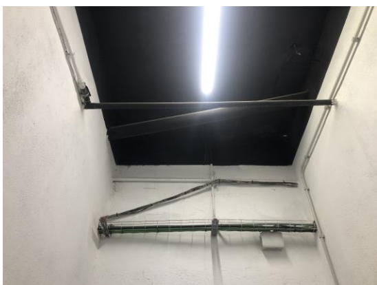
Baixants existents on connectar desguassos gabions mur verd
