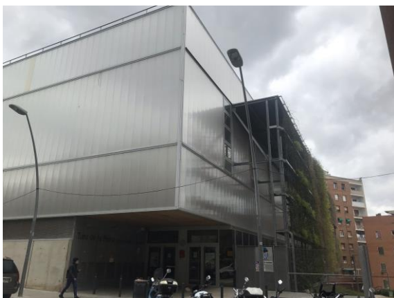
Exemple de façana de policarbonat. CEM Turó de la Peira. Barcelona
