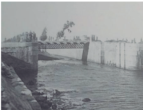
Situació actual del pas rodant actual sobre la resclosa de l'antic canal de Navegació i situació històrica prèvia (les bigues en gelosia es conserven al seu interior).
