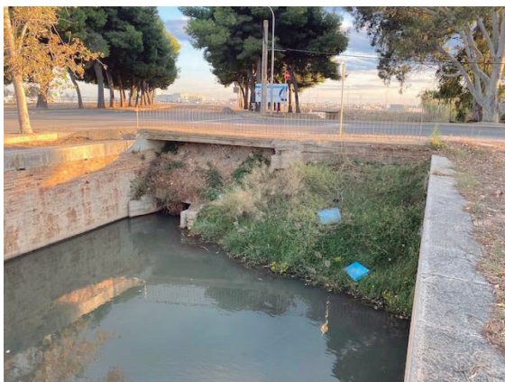
Situació actual del pas rodant actual sobre la resclosa de l'antic canal de Navegació i situació històrica prèvia (les bigues en gelosia es conserven al seu interior).
