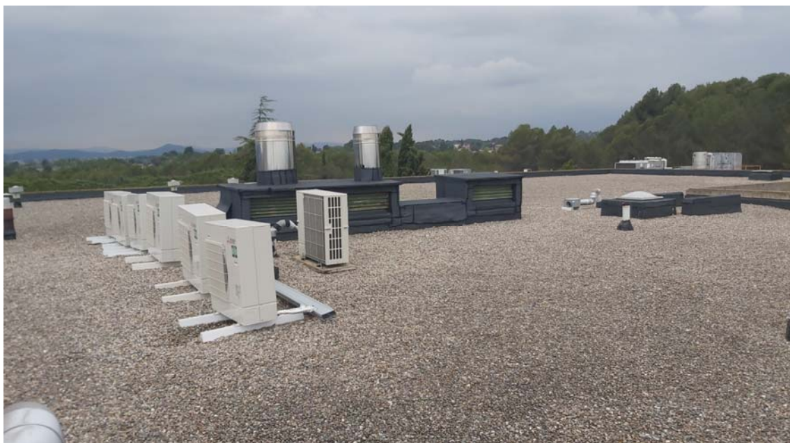
Imatge 10. Elements variis generadors d'ombreig a coberta
