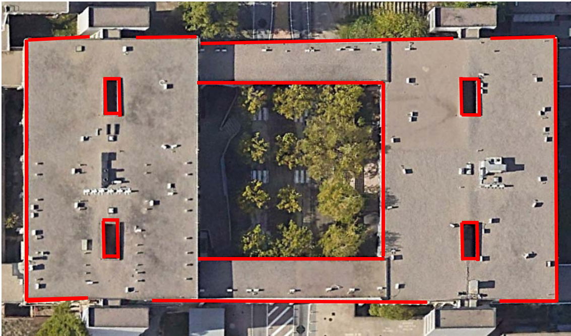
Imatge 66. Emplaçament noves baranes edificis M0 i M3
