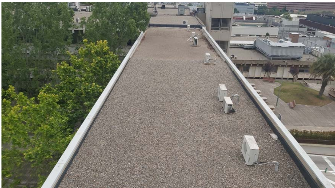
Imatge 20. Vista Espina Sud des de M3
