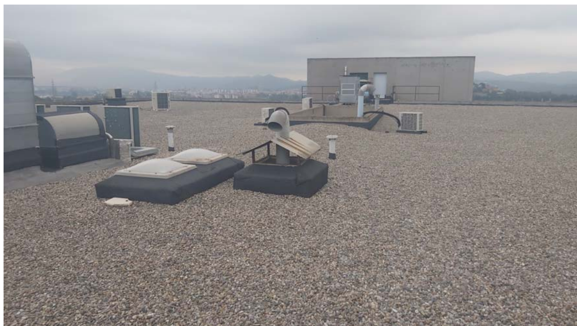
Imatge 2. Coberta edifici M0
