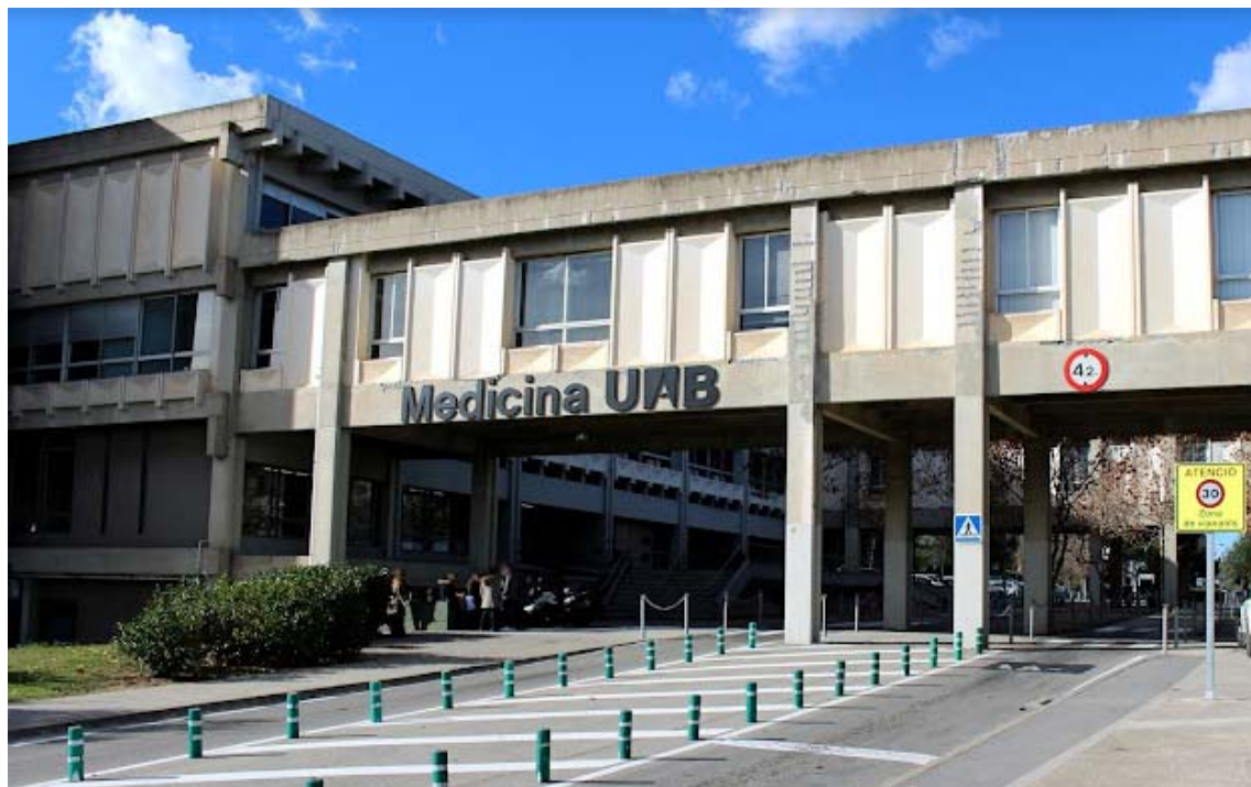
Imatge 1. Façana edifici
