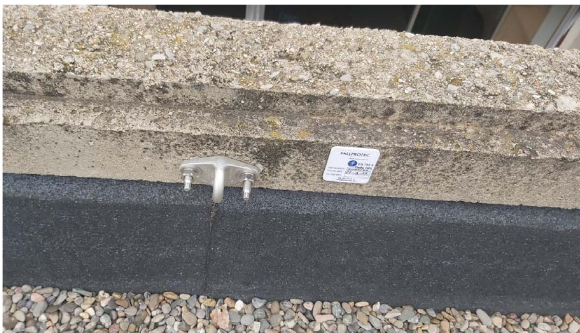
Imatge 16. Punts ancoratge existents
