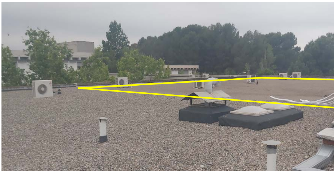
Imatge 14. Zona no rehabilitada edifici M0
