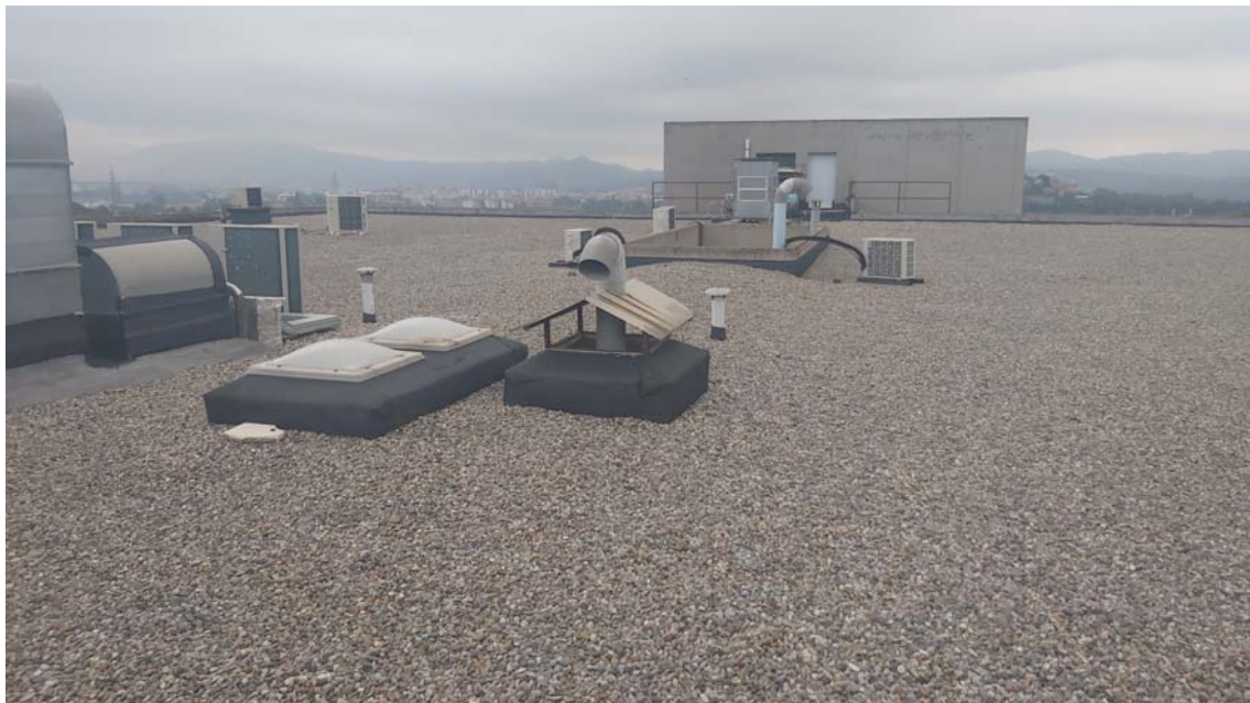
Imatge 17. Coberta edifici M0
