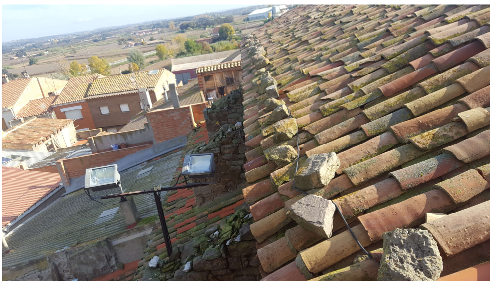
Coberta- Vessants nord i contraforts
