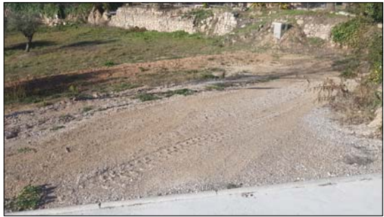
RAMPA D'ACCÉS: VISTA DES DE LA ZONA SUPERIOR
