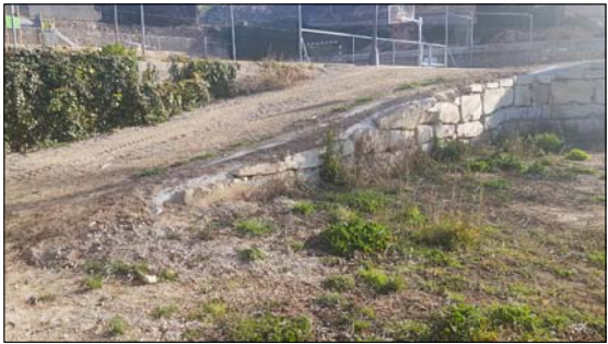
RAMPA D'ACCÉS: VISTA DES DE LA ZONA INFERIOR
