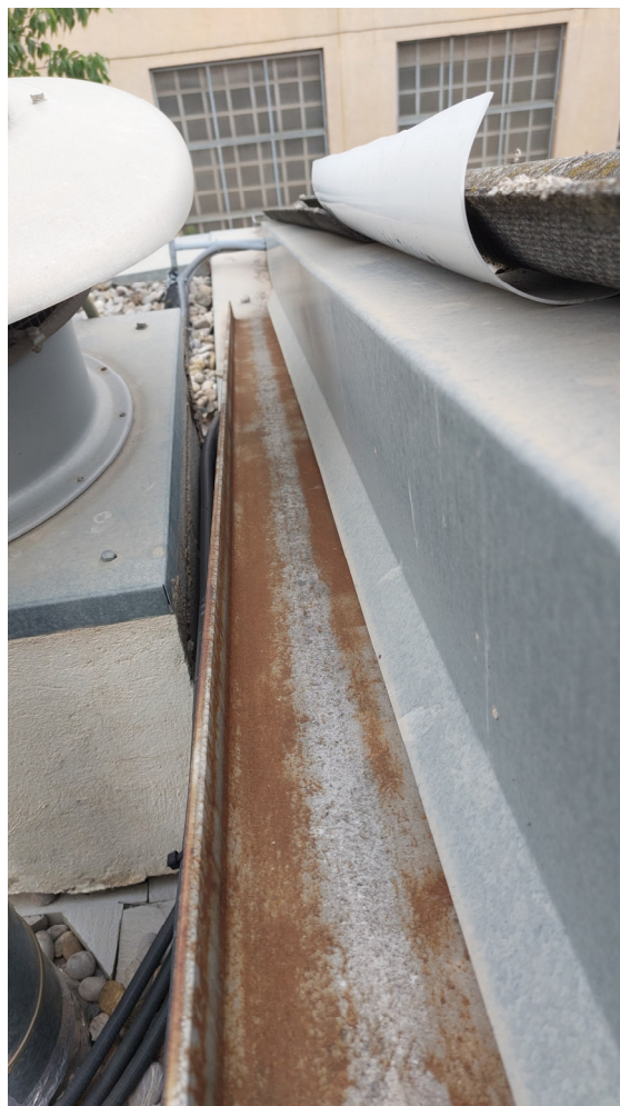
Fotografies 7 i 8. Estat actual a conservar. remat faldó lateral amb UPN-140. (per pintar)
