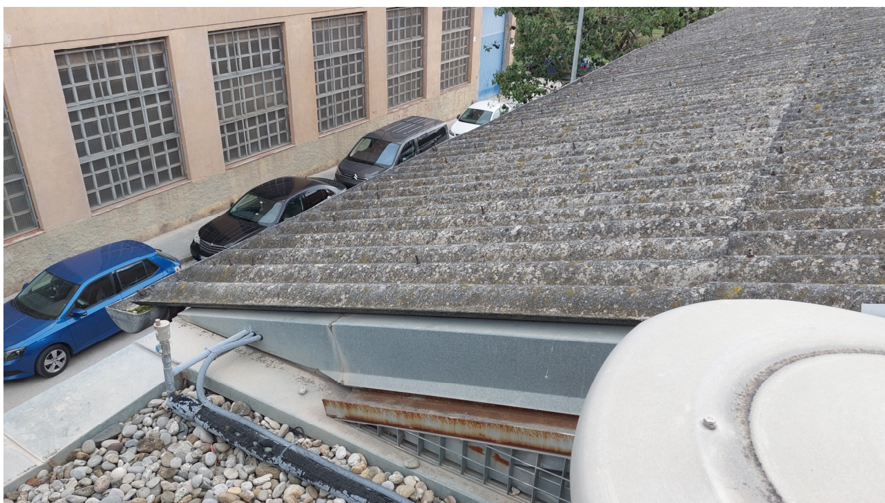
Fotografia 5. Coberta fibrociment vessant nord. pendent del 29,6 %.
