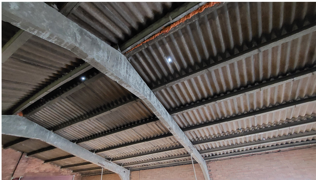
Fotografia 1. Vista general de coberta. INTERIOR. Placa ondulada de fibrociment amb amiant. Encavallades i corretges de formigó armat
