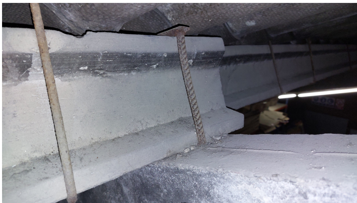
Fotografia 3. Encavalcament última corretja sobre paret de tancament. No hi ha presència d'instal·lacions
