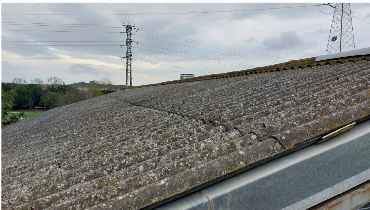
Fotografia 5. Coberta fibrociment vessant nord. pendent del 29,6 %.
