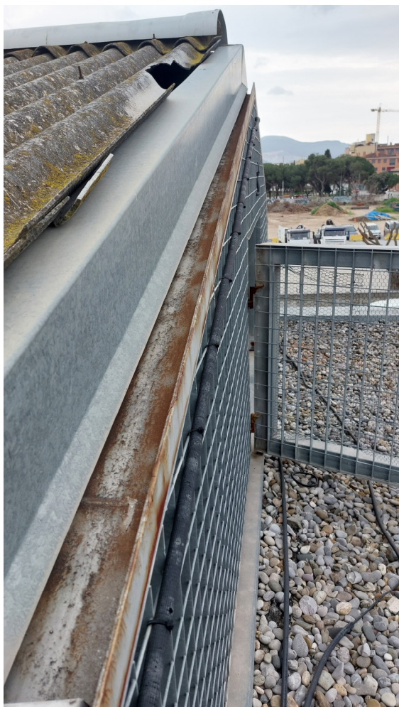
Fotografies 7 i 8. Estat actual a conservar. remat faldó lateral amb UPN-140. (per pintar)
