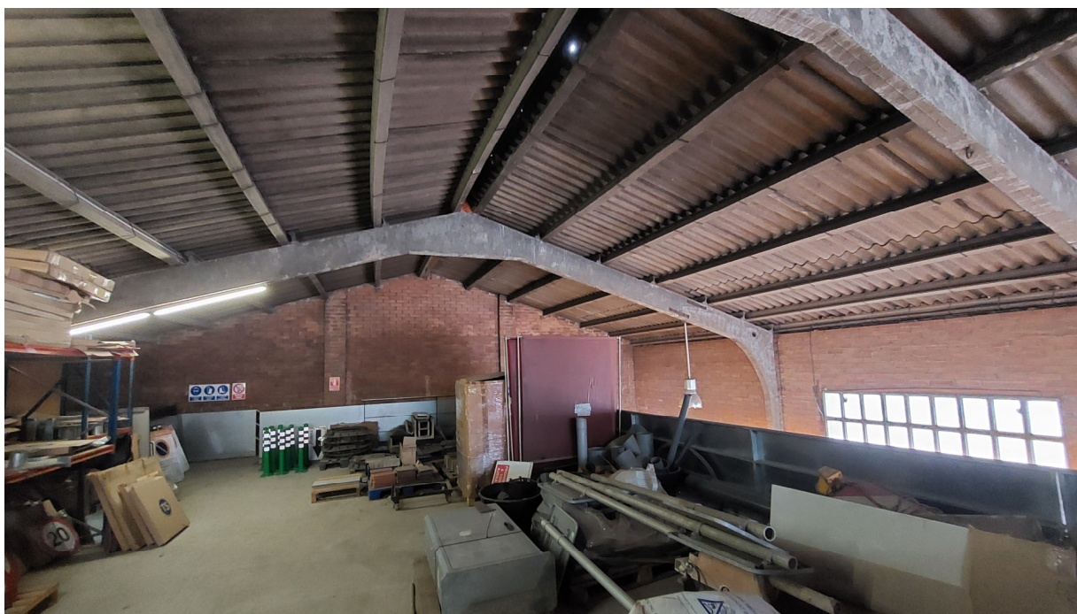
Fotografia 1. Vista general de coberta. INTERIOR. Placa ondulada de fibrociment amb amiant. Encavallades i corretges de formigó armat
