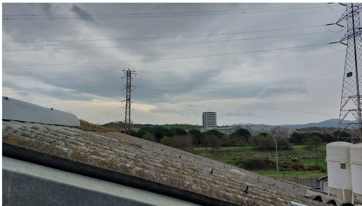
Fotografia 9. Estat actual Coberta fibrociment vessant sud.
