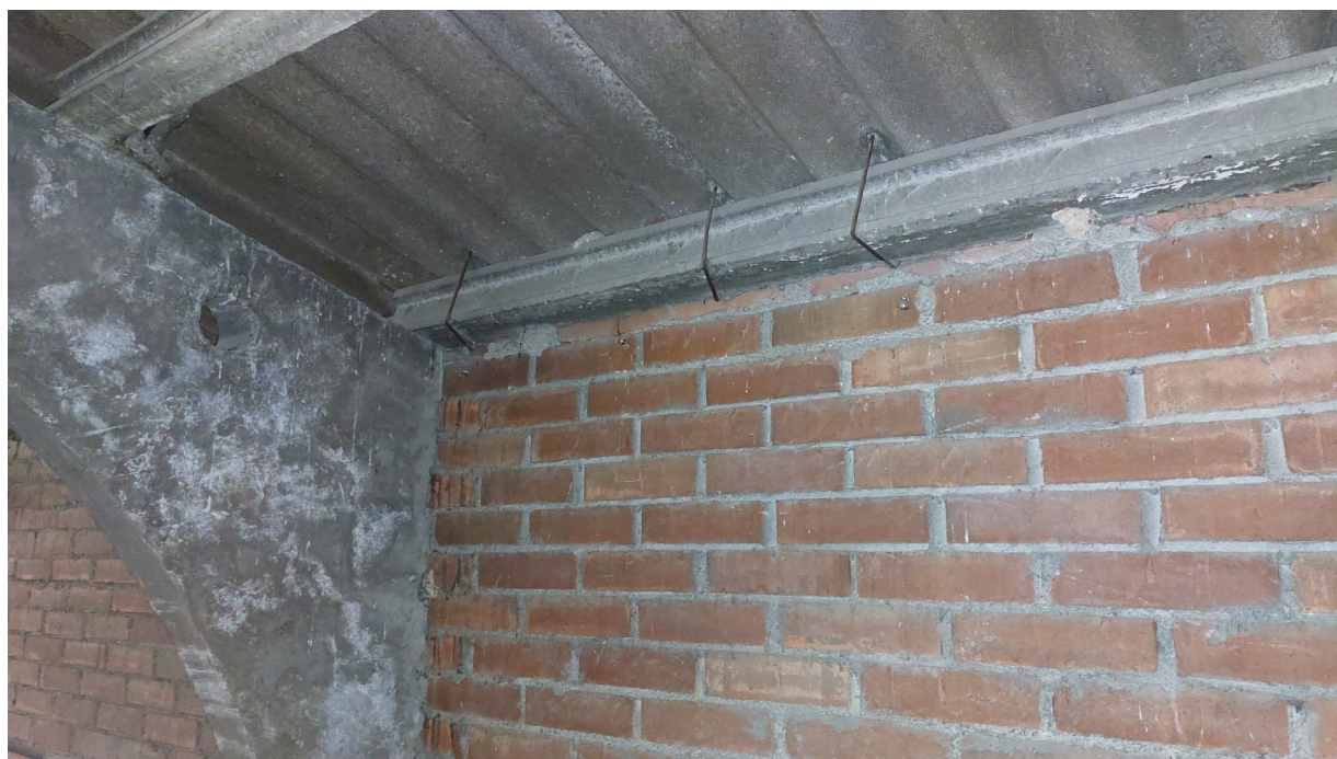
Fotografia 3. Encavalcament última corretja sobre paret de tancament. No hi ha presència d'instal·lacions
