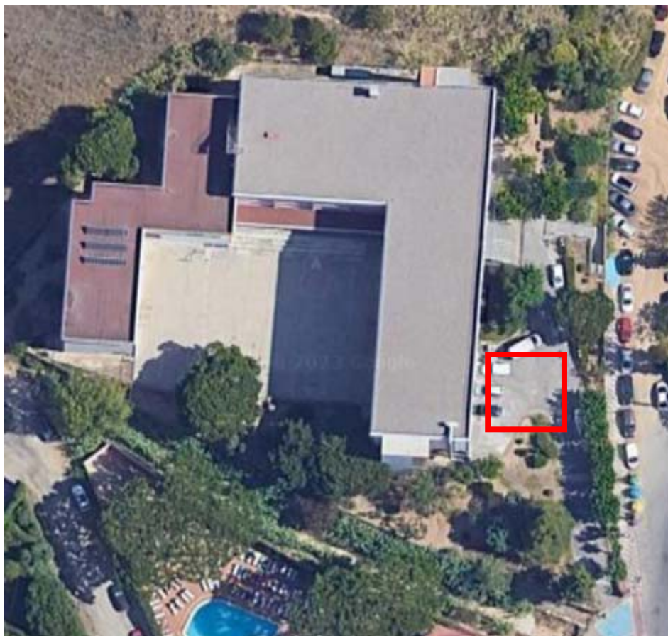
Il·lustració 12. Zona habilitada per pujada de material
