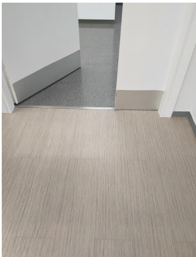
Figura 16: Platina canvi paviment, en porta accés mòduls.
