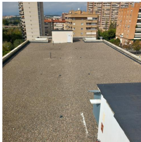
Figura 4 Cobertes Institut Martí i Franquès. Font: Infraestructures.cat
