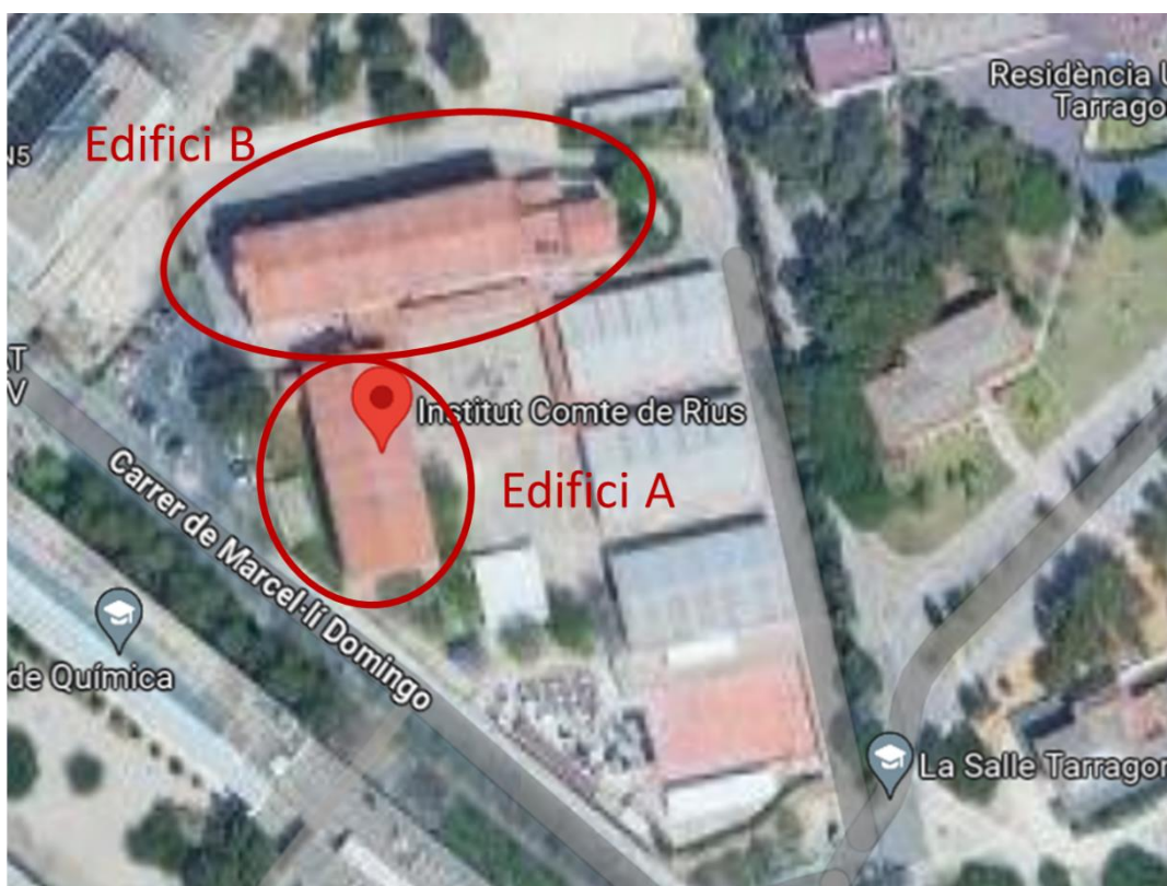
Figura 3 Edificis objecte de projecte. Font: Google Maps
