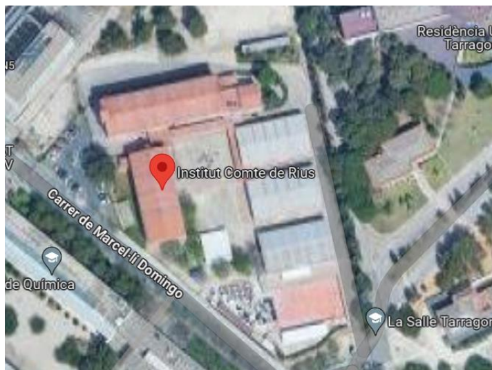
Figura 1 Emplaçament objecte d'execució d'obra. Font: Google Maps
