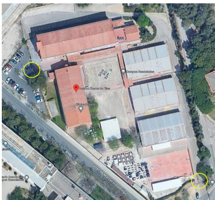
Figura 12 Portes d'accés a parcel·la Institut Comte de Rius. Font: Google Maps, Infraestructures.cat
