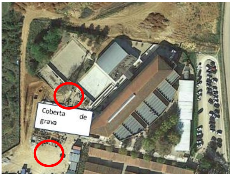
Il·lustració 8: Zona habilitada per pujada de material
