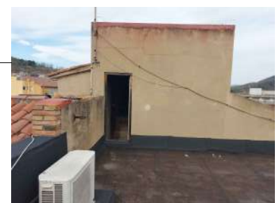
PUNT ACCÉS A COBERTA
