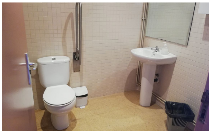
FIG. 18 - PORTA SERVEI HIGIÈNIC ADAPTAT (a substituir per una corredissa)
