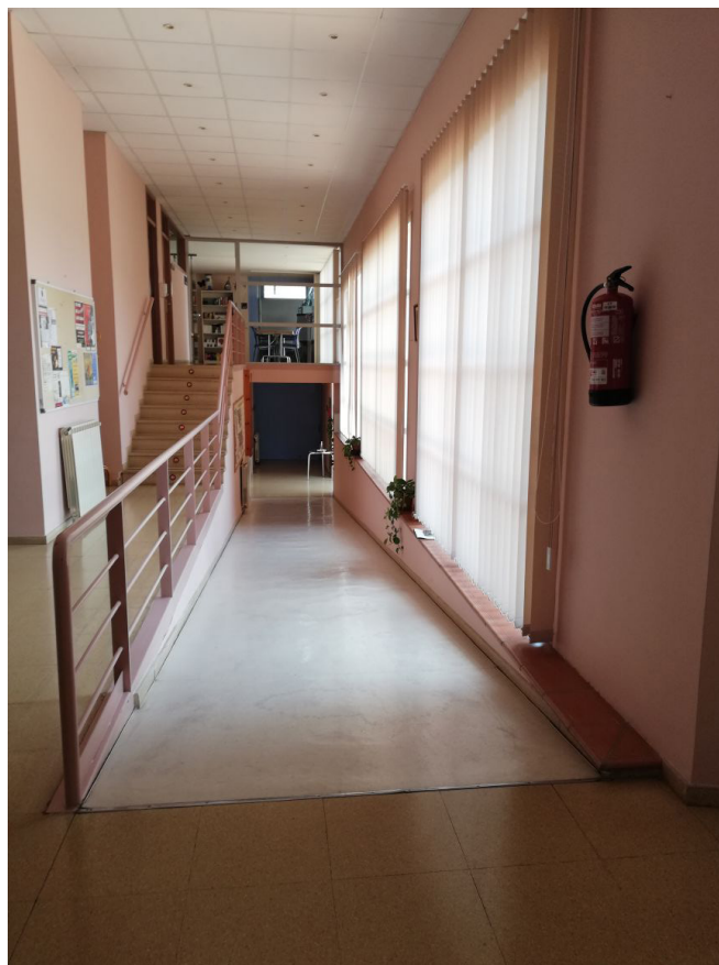
FIG. 14 i 15 - RAMPA ON ES COL·LOCA EL PASSAMÀ PEL COSTAT QUE DONA A LA FAÇANA
