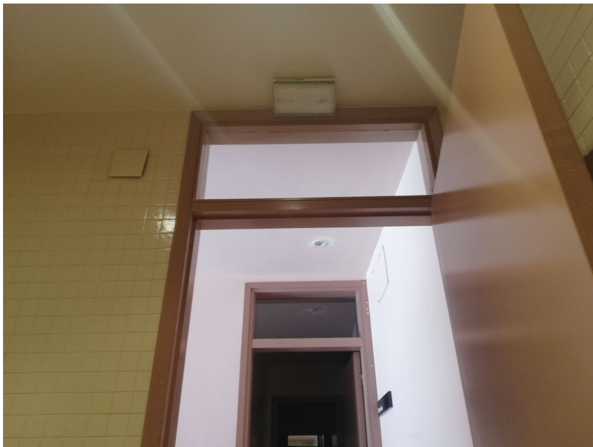
FIG. 18 - PORTA SERVEI HIGIÈNIC ADAPTAT (a substituir per una corredissa)
