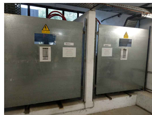
4: ZONA ESTACIÓ TRANSFORMADORA
