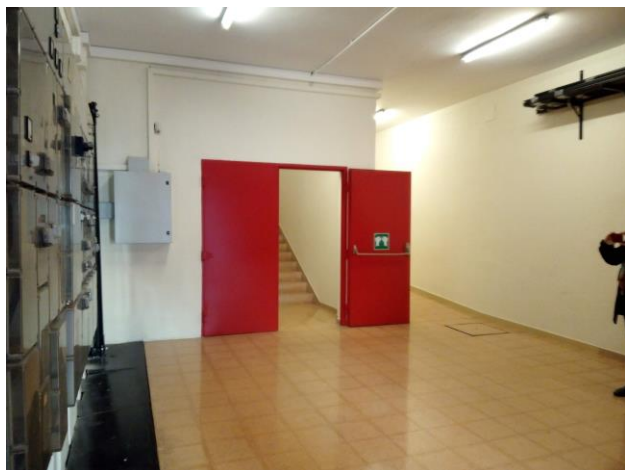
Foto 10. Vestíbul edifici de serveis
