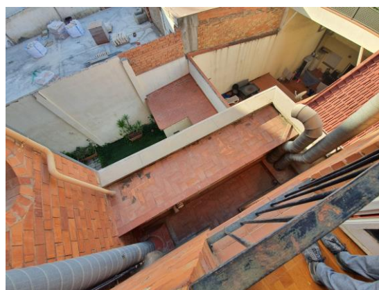
Foto 25. Pati sobre cafeteria
