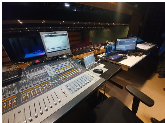
Foto 21. Sala A cabina de control
