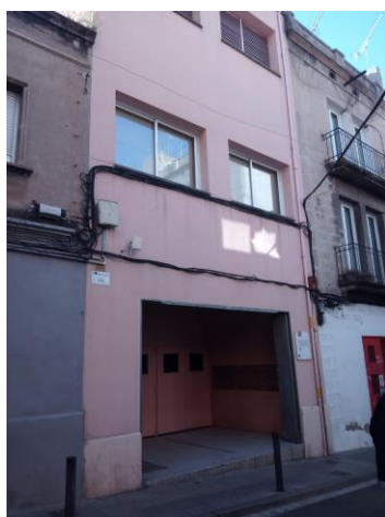
Foto 06. Façana carrer Pujós
