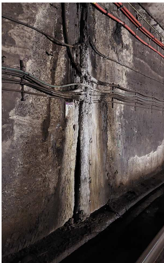
Imatge 19. Filtració PK110+900 hastial via 1
