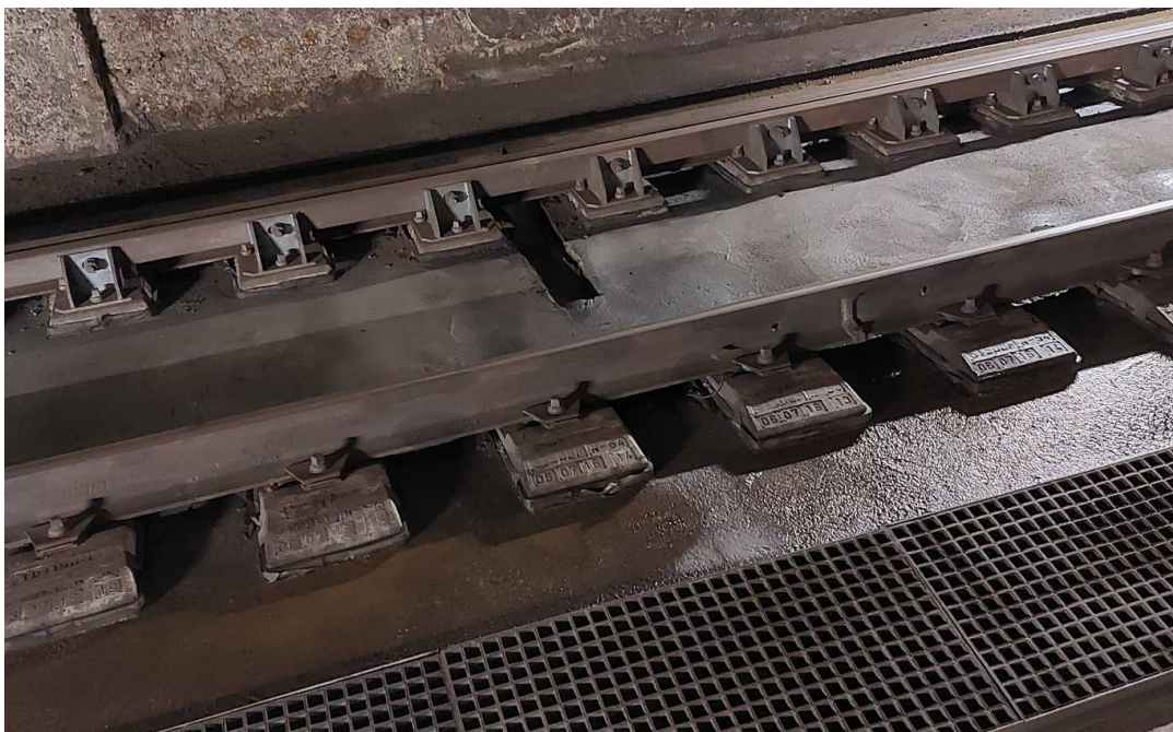
Imatge 18. Exemple drenatge transversal a obrir
