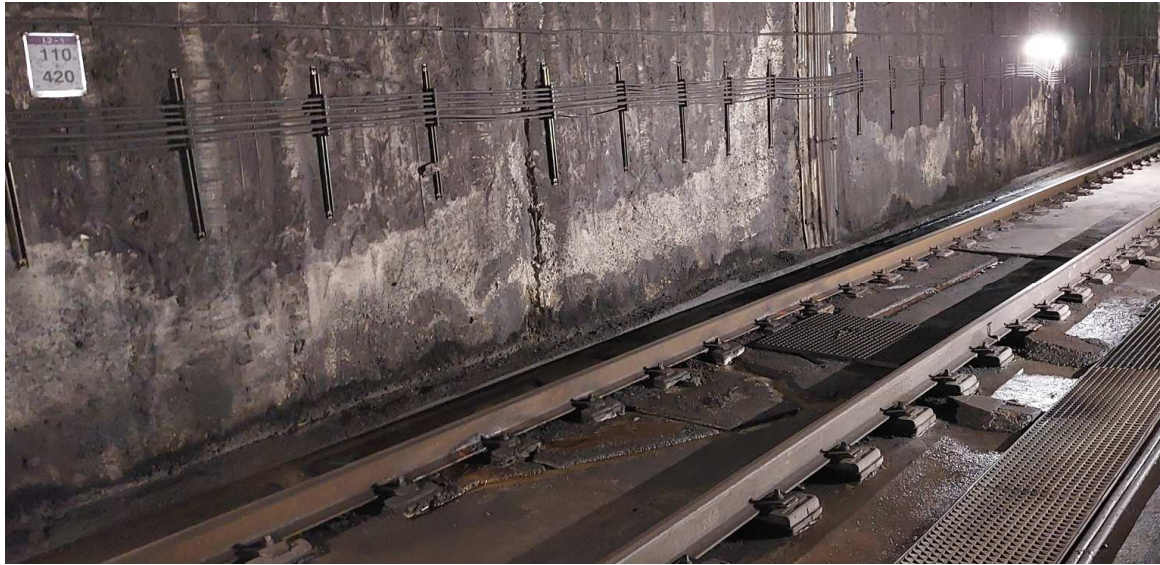
Imatge 17. Fotografia drenatge transversal a millorar PK 110+420 de via 1.
