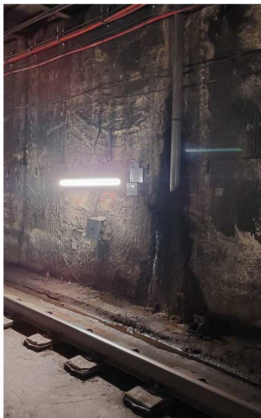
Imatge 20. Tub sense completar PK110+912
