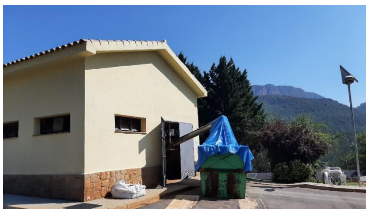
Situació del contenidor i lloc on s'instal·larà la coberta
