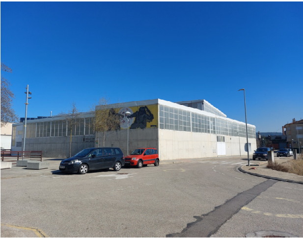
Vista exterior del pavelló
