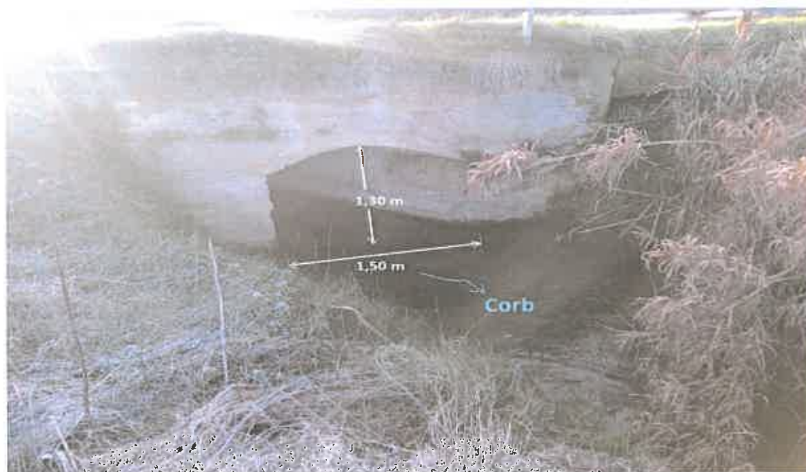
Fotografia 1. Secció existent en tota l'amplada del pont. Fotografia presa aigües avall del pont de la Carretera L-334.
