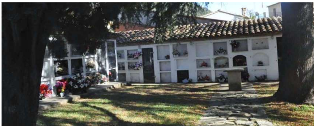
L'espai del cementiri actual amb paviments de pedra i graons no adaptats a les condicions d'accessibilitat
